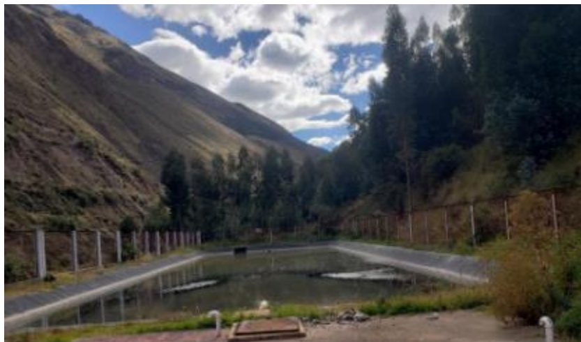
Figura N° 2: Excavaciones en construcciones laguna de estabilización de la PTAR.
