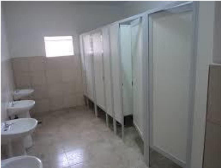
FIGURA 5 : Espacio impermeable –aulas
