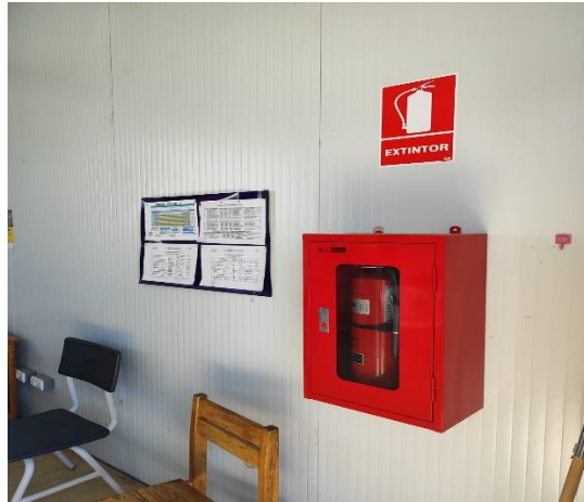
Fig. 38. Instalación de señalización y extintor en Dirección.
