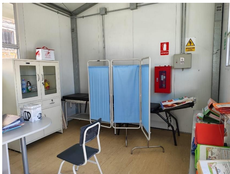
Fig. 37. Instalación de señalización y extintor en área de Psicología.
