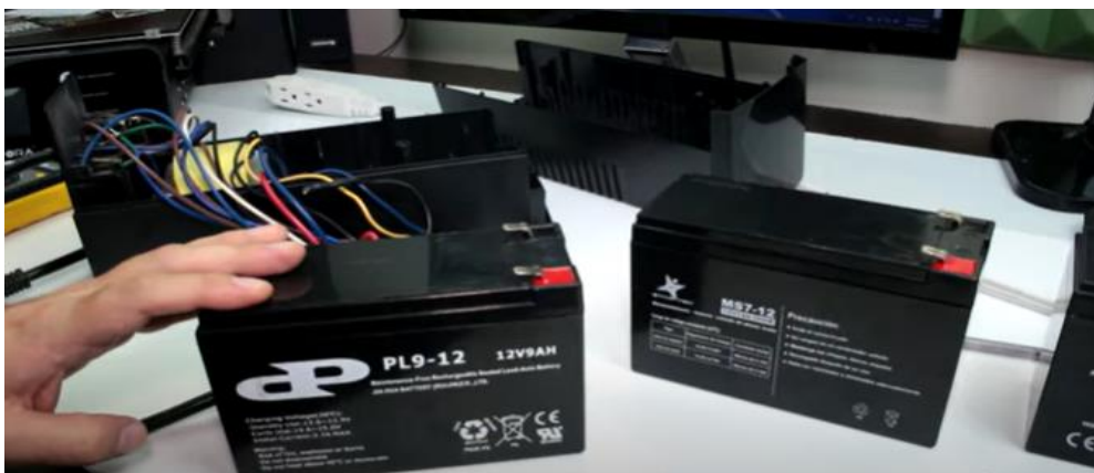
Fig. 29. Instalación de UPS para aula de innovación.
