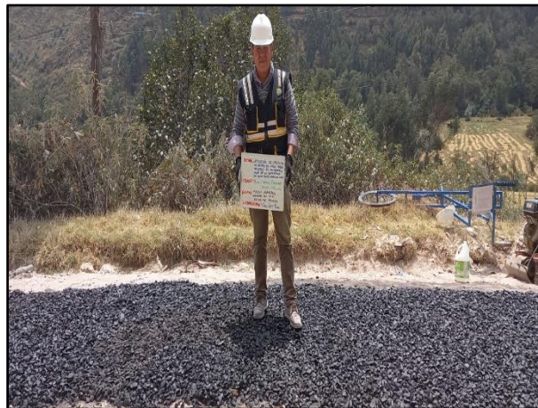
Fotografía N° 32: Capa de rodadura de mezcla asfáltica abierta en frío de tramo de prueba según la referencia de la Manual MTC - EG2013.
