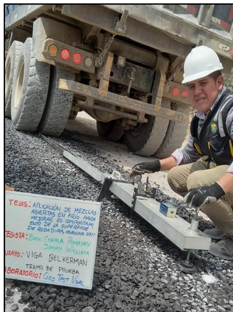
Fotografía N° 38: Medición de deflexiones y deformaciones sobre la capa de rodadura por el peso de camión de 8 toneladas, según referencia de la norma (ASTM D 4695).
