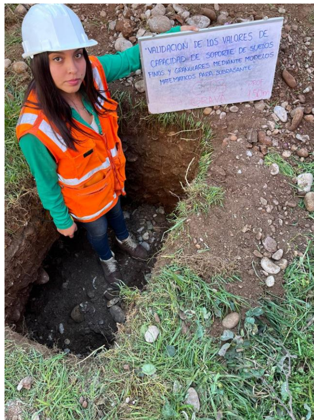
Fotografía 2. Vista de la calicata para la extracción de la muestra C – 03.
