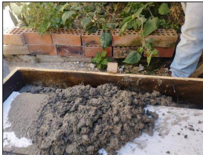
Fotografía 14. Vaciado del concreto en los moldes estructurales para losas.
