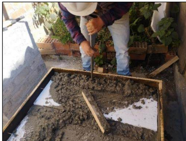
Fotografía 15. Vibración del concreto en el vaciado de losas.
