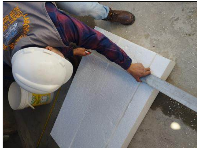
Fotografía 5. Elaboración de casetas de Tecnopor para losas aligeradas.
