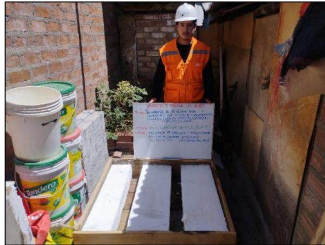
Fotografía 17. Realización del molde estructural para la losa de concreto
