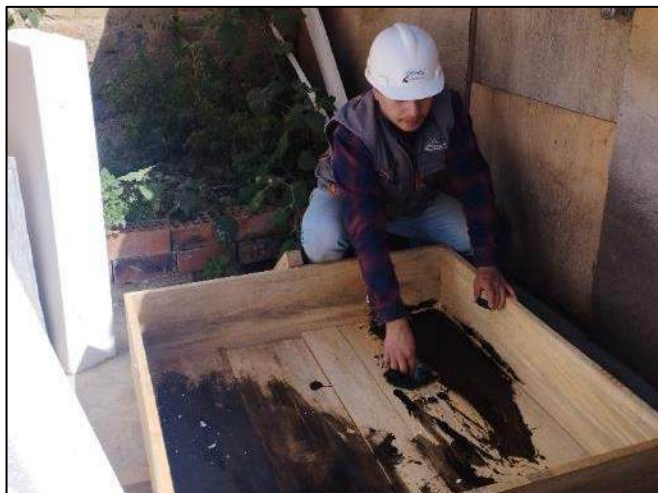
Fotografía 6. Elaboración del molde para losas aligeradas.
