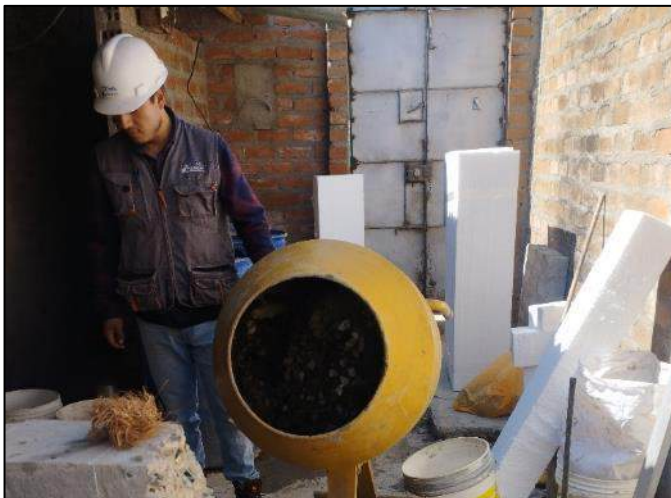
Fotografía 12. Vaciado del concreto con la adición de fibra de coco.
