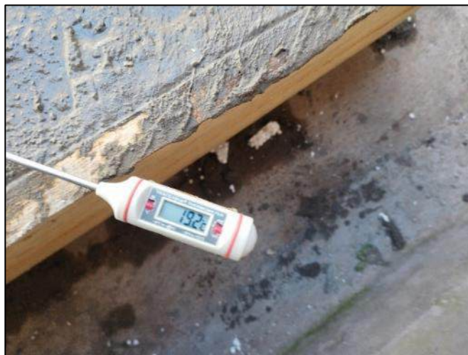
Fotografía 19. Medición de la temperatura del concreto.
