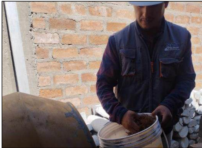
Fotografía 11. Adición de fibra de coco en la mezcla.
