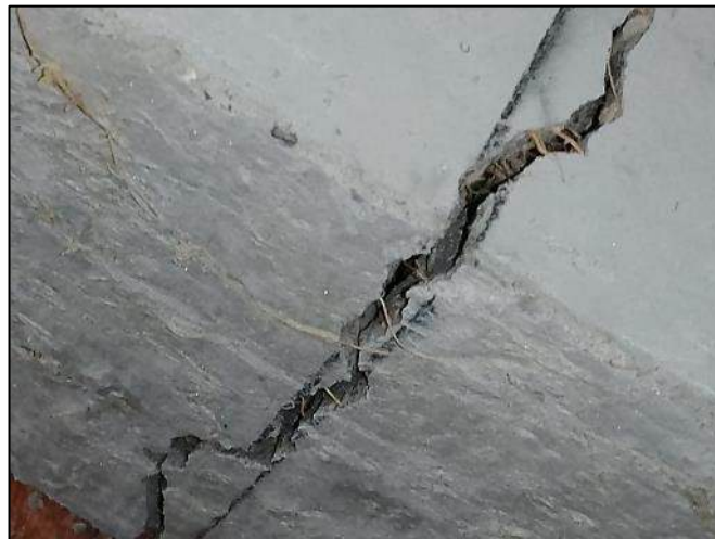
Fotografía 29. Fisura luego de la ruptura de la probeta
