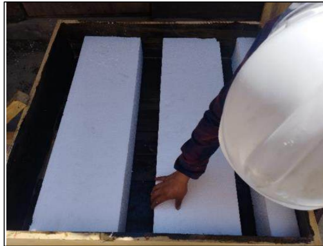
Fotografía 8. Inclusión de las casetas de Tecnopor para las losas.
