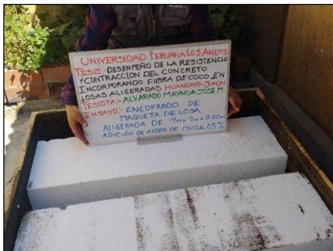
Fotografía 9. Realización del encofrado de maqueta de losa.
