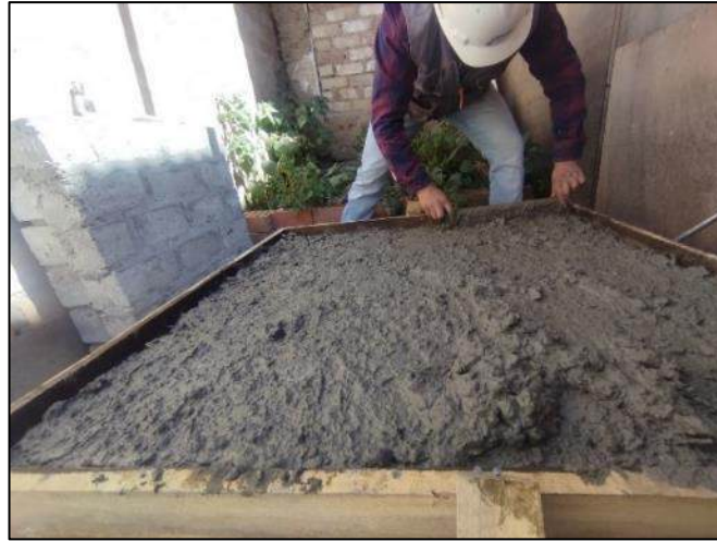
Fotografía 16. Realización del regleo en losas de concreto.
