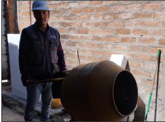
Fotografía 10. Elaboración de la mezcla para losa de concreto
