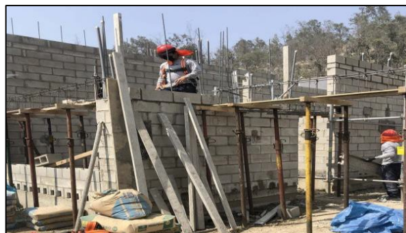
Figura 3. Construcción de viviendas con bloques.
