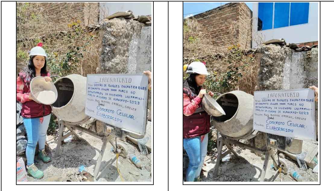
Fotografía No. 7: Elaboración de la muestra convencional y concreto celular.
