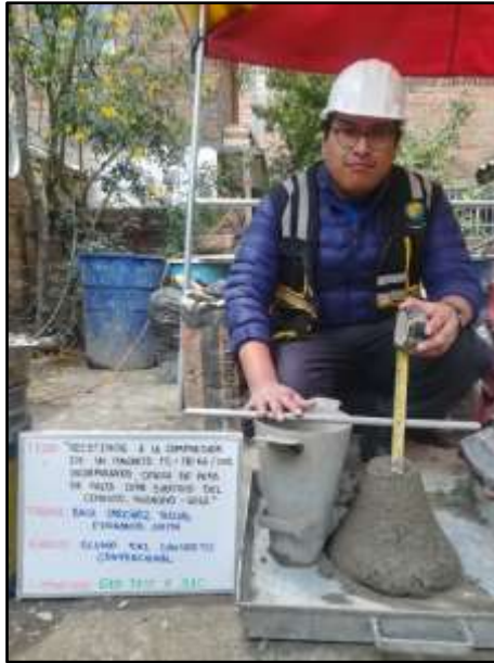
Fotografía N° 1: Medición del asentamiento del concreto convencional. Según NTP 339.035.
