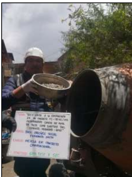
Fotografía N° 3: Vista de materiales tales como el agregado grueso para la elaboración del concreto convencional, según referencia de la norma NTP 339.183.
