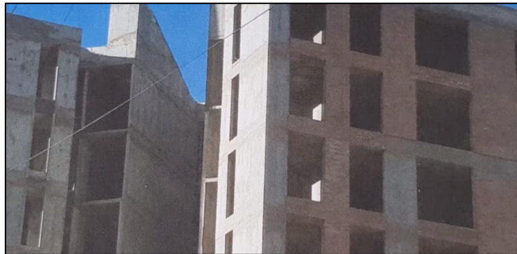
Figura N° 15. Placas de concreto armado
