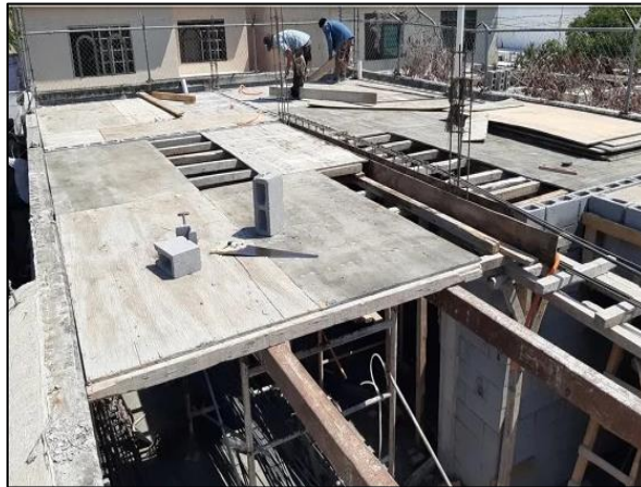
Figura N° 13. Losa de entrepiso
