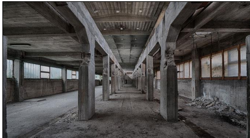
Figura N° 14. Viga (elemento estructural)
