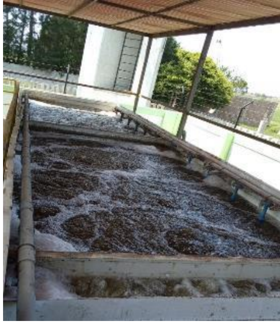
Figura 9. Reactores MBBR
