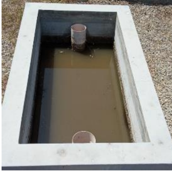
Figura 7. Proceso de la trampa de grasa
