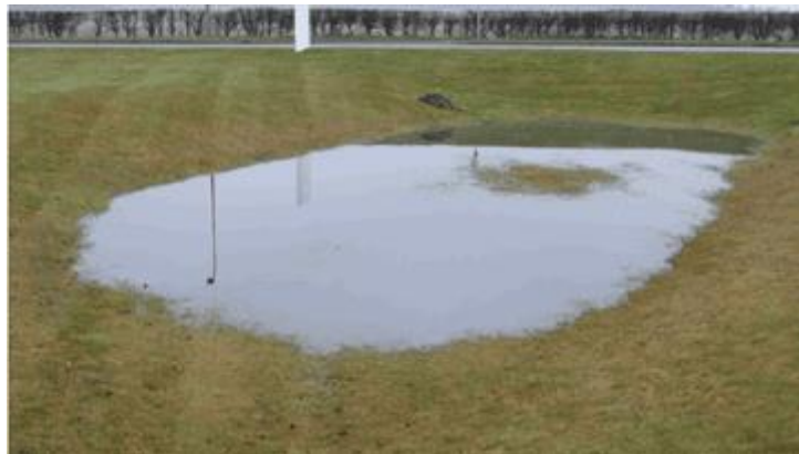
Figura N° 16: Depósito de infiltración.
