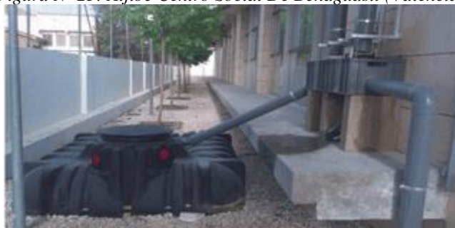
Figura N° 23: Aljibe Centro Social De Benaguasil (Valencia).
