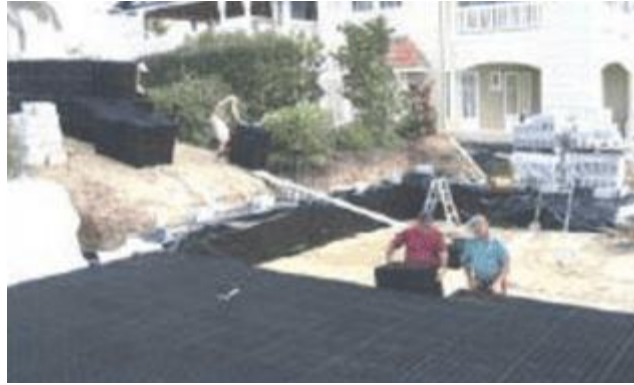
Figura N° 19: Depósito de detención enterrado.
