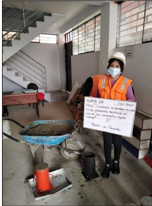
Fotografía N° 9 : Elaboración de testigos de concreto, con la adición de 2% de alambre reciclado.
