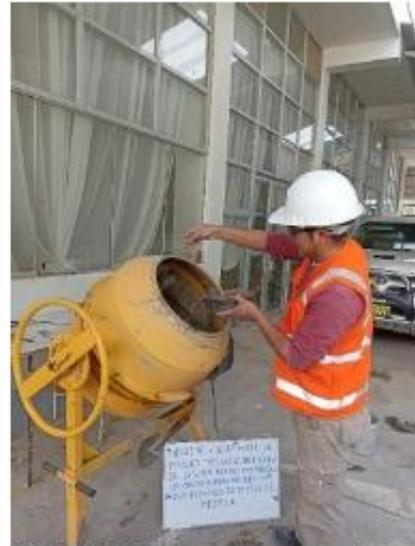
IMAGEN N° 28: Preparación de mezcla (adición de fibra de magüey).
