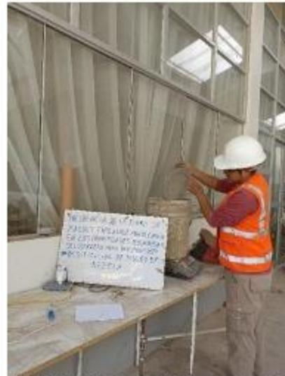
IMAGEN N° 19: Diseño de Mezcla (peso de cemento).
