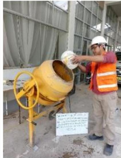
IMAGEN N° 24: Preparación de mezcla (agua).
