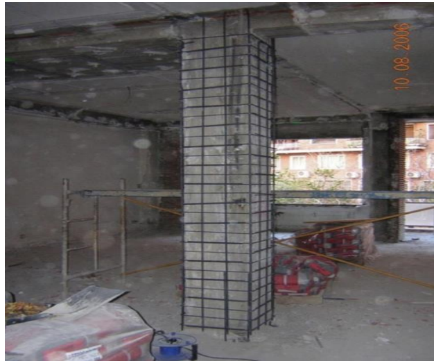
Figura 31: Encamisado de concreto
