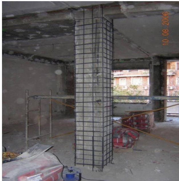
Figura 4: Encamisado de concreto
