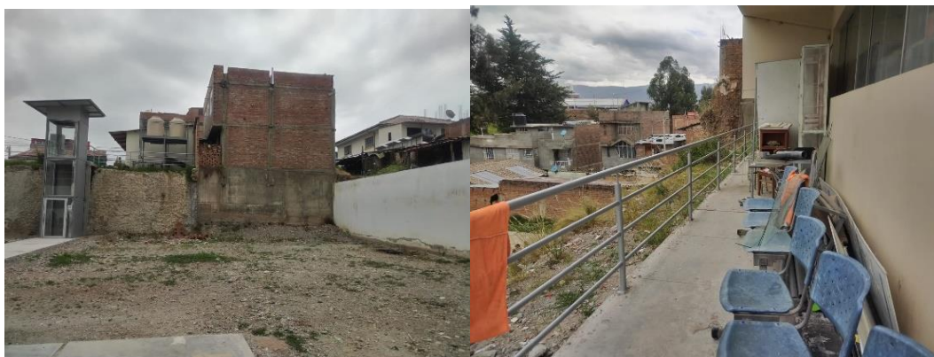
Figura 1. 1 Fotografía del estado situacional del Instituto - Elaboración propia.
