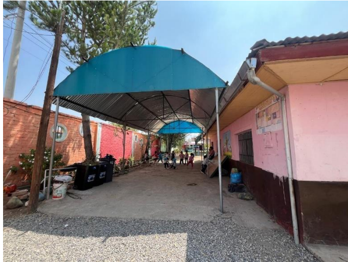
Camino con cobertura de calamina
