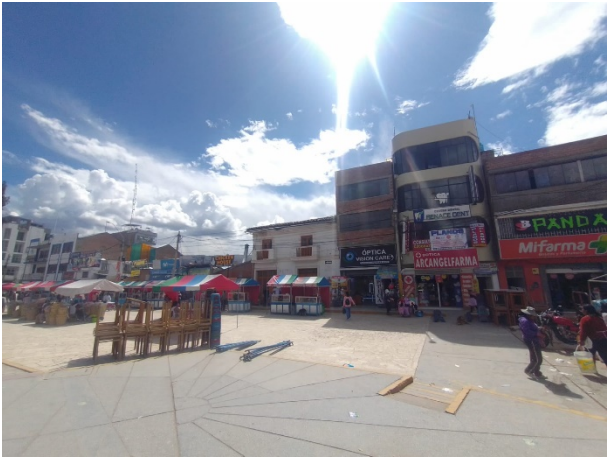
Figura 36. Vista tramo B6
