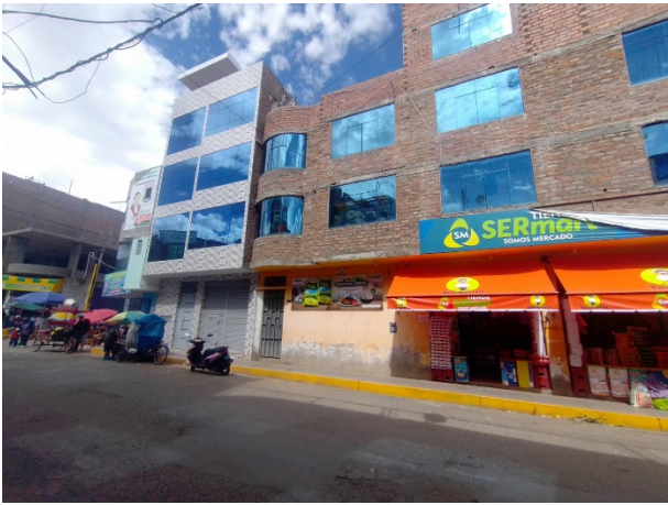
Figura 25. Vista tramo A5
