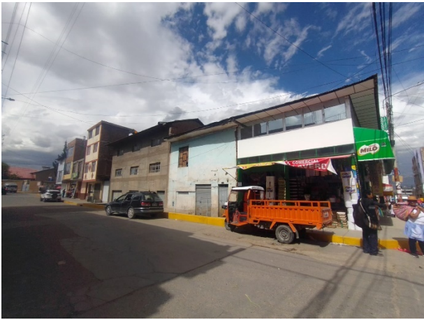
Figura 28. Vista tramo A9
