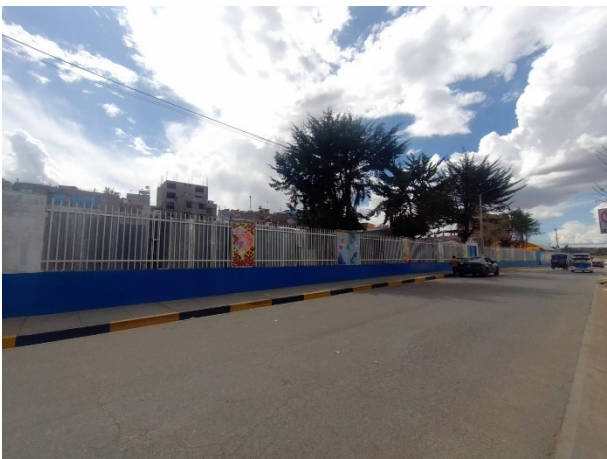
Figura 29. Vista tramo A10
