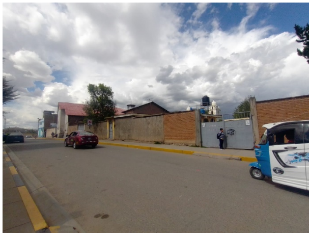
Figura 30. Vista tramo A11
