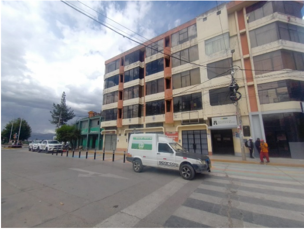
Figura 40. Vista tramo B11
