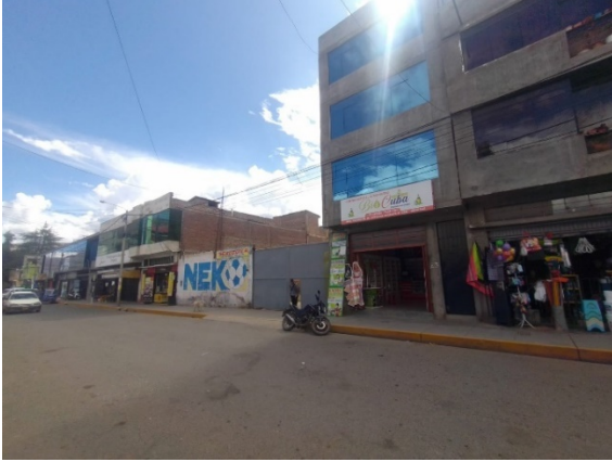
Figura 21 Vista tramo A1
