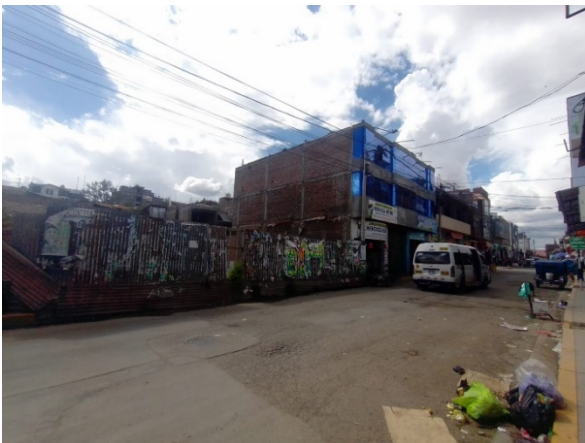
Figura 23. Vista tramo A3
