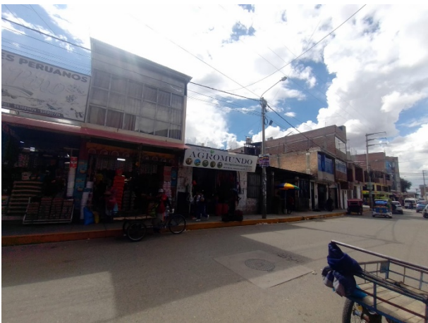
Figura 26. Vista tramo A6
