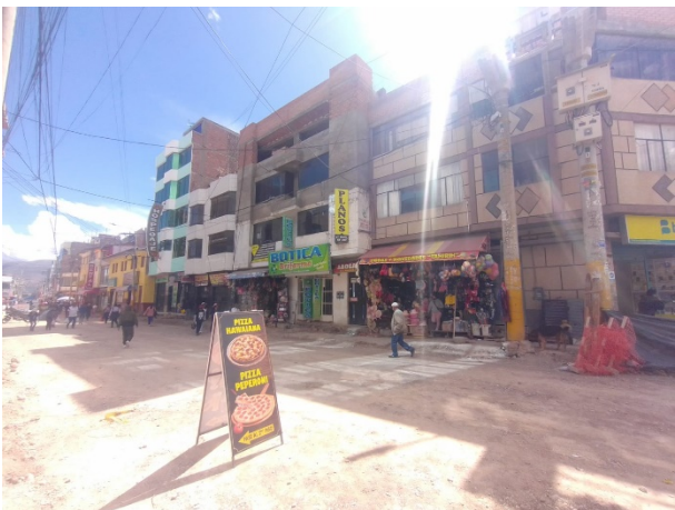
Figura 38. Vista tramo B8
