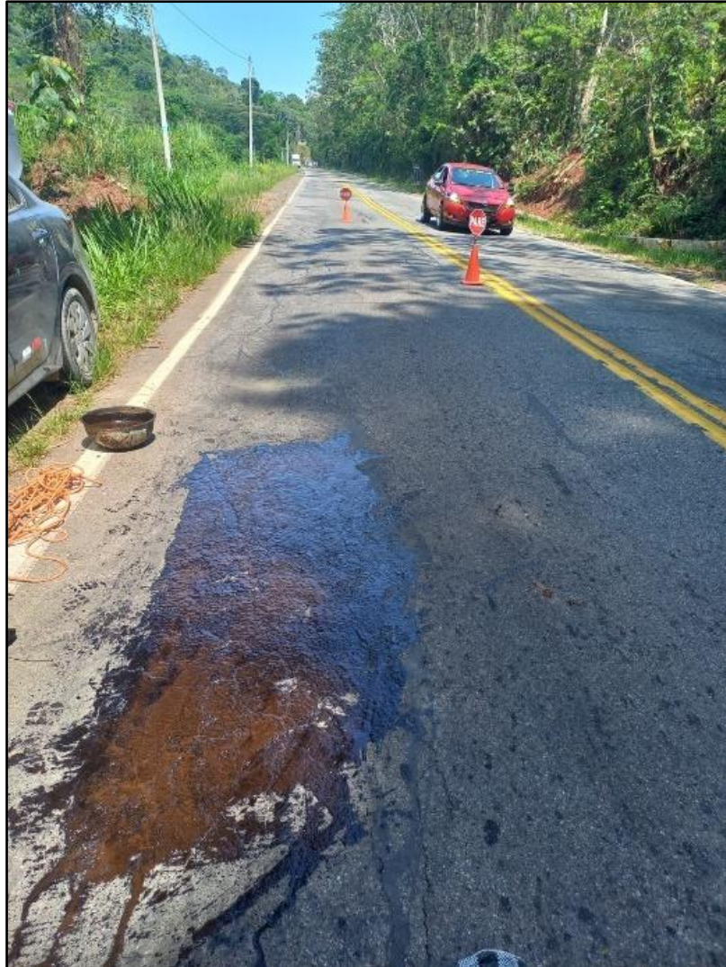
Fotografía 17: Imprimación con emulsión asfáltica tipo CSS-1H, elaboración de tratamiento superficial bicapa, Slurry seal en tramo 02 carretera Acobamba - Palcamayo en zonas afectadas según la referencia de la Manual MTC - EG2013.
