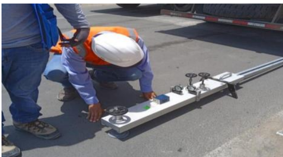
Figura 14. Surcos en pavimento.
