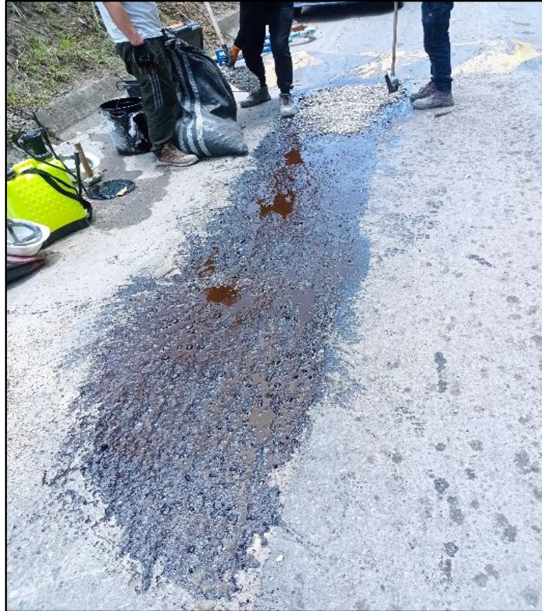
Fotografía 16: Imprimación con emulsión asfáltica tipo CSS-1H, elaboración de tratamiento superficial bicapa, Slurry seal en tramo 01 carretera Acobamba - Palcamayo, en zonas afectadas según la referencia de la Manual MTC - EG2013.
