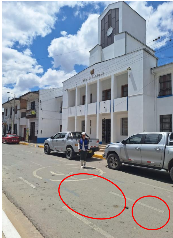
Fotografía 10: Carretera Acobamba. Daño de Capa Asfáltica Final de Tramo.
