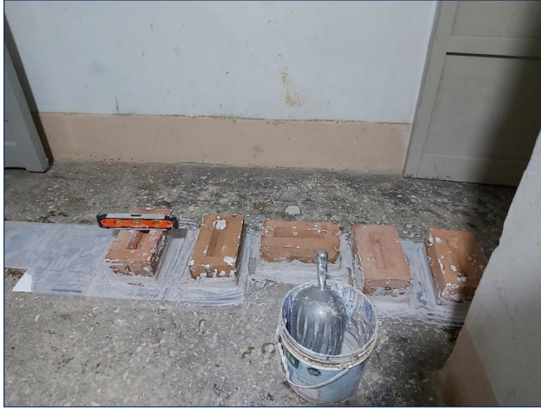
Figura 19. Ladrillos cubiertos de yeso.
