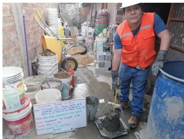
Figura 12. Ensayo de asentamiento
