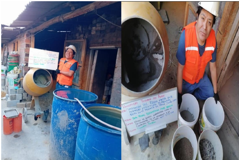
Relave y cemento a la mezcladora
