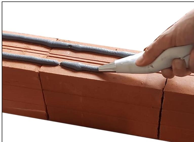
*Figura 3:* Mortero polimérico.
