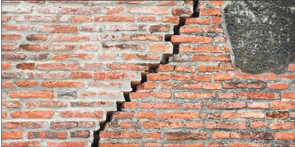
*Figura 1:* Fallas en juntas de muro de albañilería con ladrillos.
