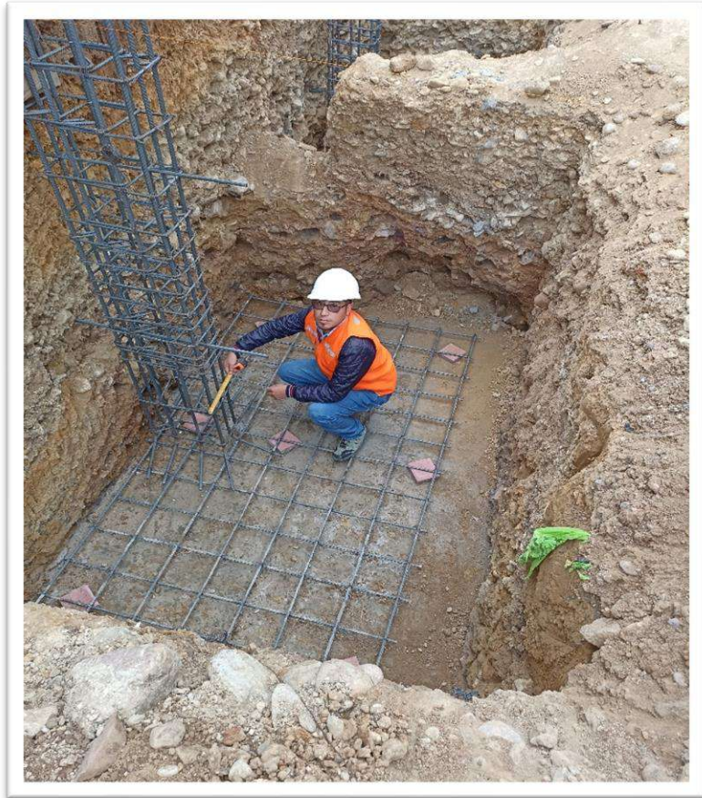
Vista 03.- En la vista se observa la toma de medida de los estribos de la columna.
