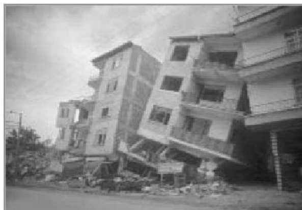
Figura 5 Desplazamiento lateral y ruptura columnas
