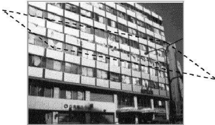
Figura 4 Colapso del quinto piso por piso débil
