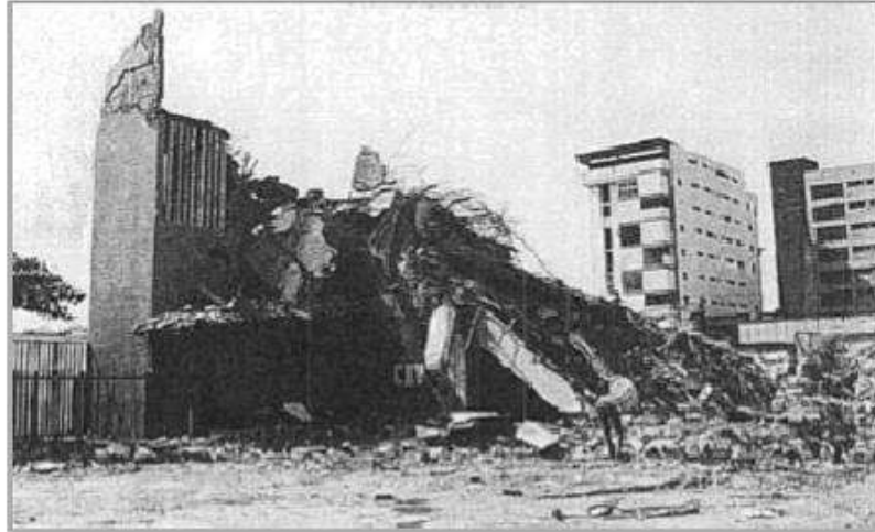
Figura 15 Edificio Miramar-Cumana. Después del terremoto de 1997
