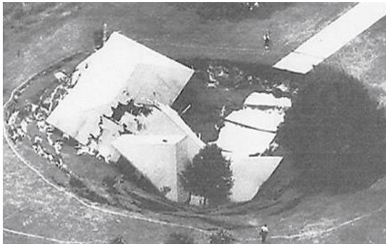
**Figura 25.** Colapso del terreno y hundimiento de la estructura.
