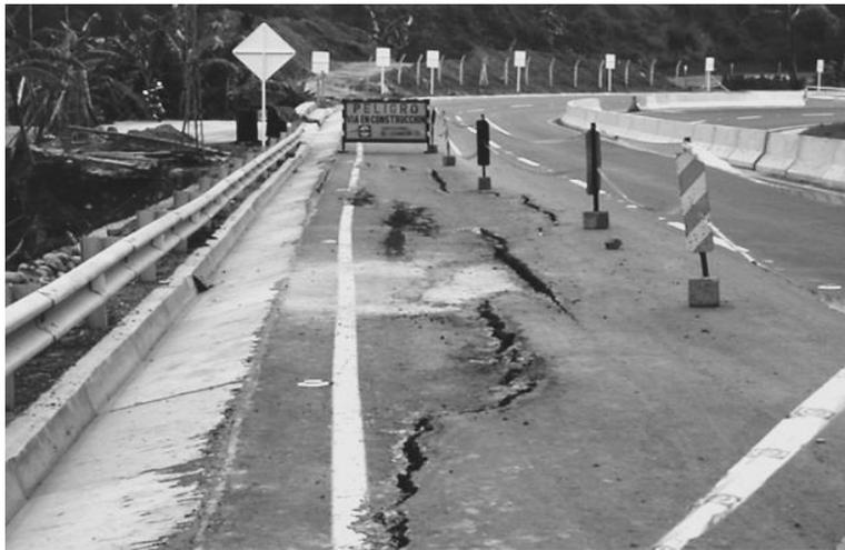
**Figura 26.** Falla de un muro MSE por exceso de deformación en los refuerzos.
