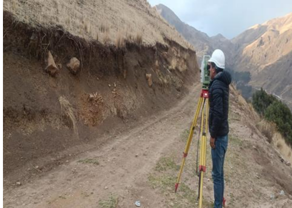
Figura 3 Levantamiento topográfico del Centro Poblado de Cuñas
