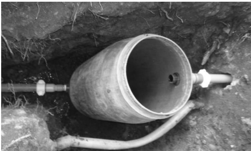
Figura 5.29. Instalación de los filtros de carbón activo granular Fuente: Elaboración propia.
