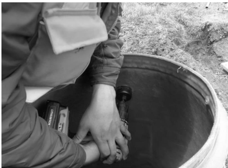
Figura 5.27. Construcción de los filtros de carbón activo granular Fuente: Elaboración propia.
