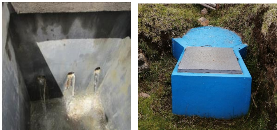
Figura 5.7. Vista externa e interna de la captación n° 01 Fuente: Elaboración propia.
