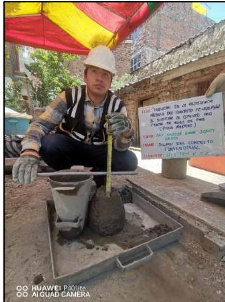
Fotografía N° 11: Medición del asentamiento del concreto convencional. Según NTP 339.035.
