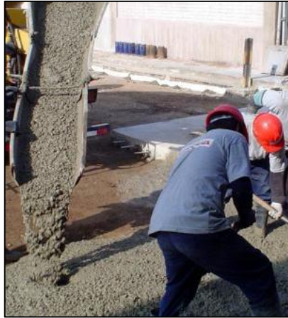
Figura N° 9. Concreto fresco en obra
