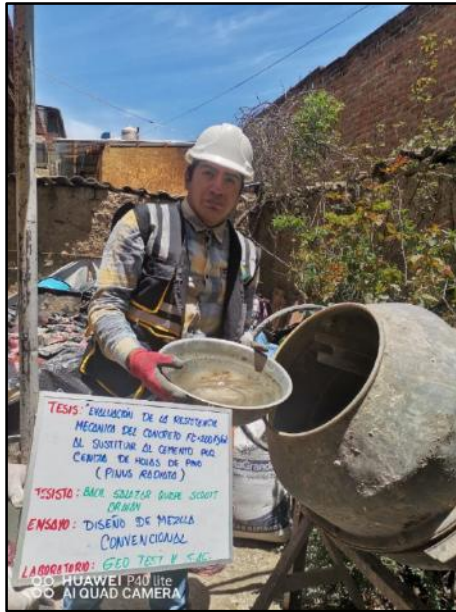
Fotografía N° 9: Vista de materiales tales como el agua para la elaboración del concreto convencional, según referencia de la norma NTP 339.183.
