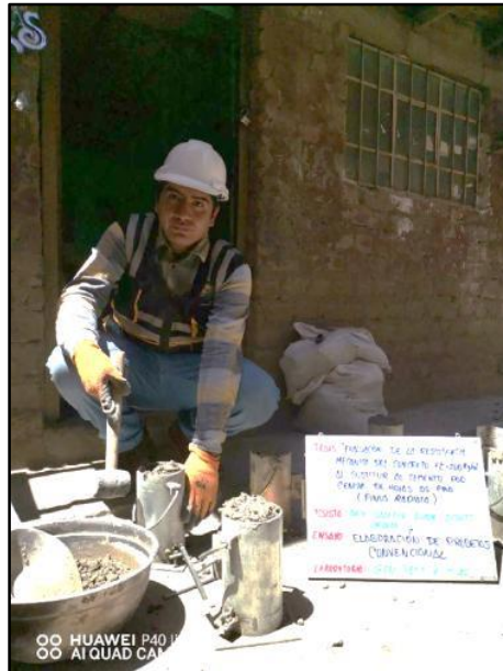
Fotografía N° 15: Elaboración de testigos cilíndricos convencional para sus respectivos tipos de ensayos. NTP 339.034 / ASTM C39.
