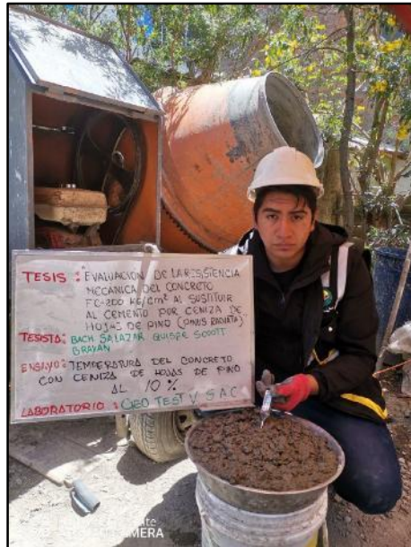
Fotografía N° 21: Medición de la temperatura del concreto saliendo de la mezcladora con 10% de ceniza de hojas de pino. NTP 339.184.
