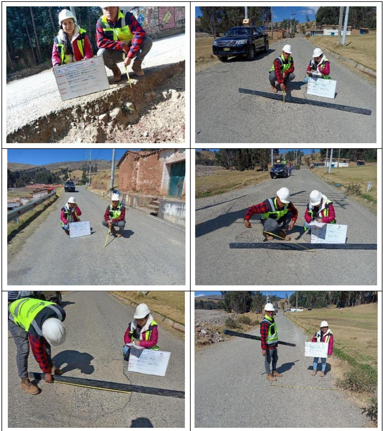
Fotografía N° 1: Inspección visual e identificación de fallas del tramo.
