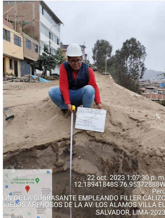
Fotografía 3. Exploración de la calicata N°3
