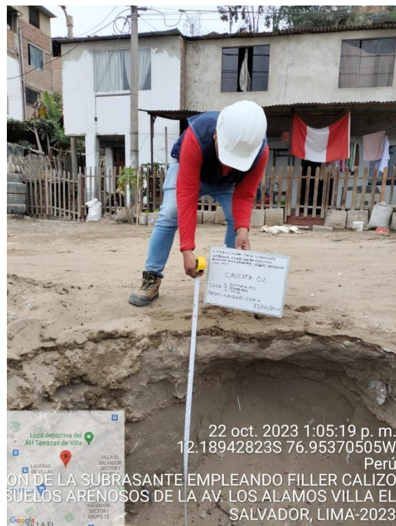
Fotografía 2. Exploración de la calicata N°2
