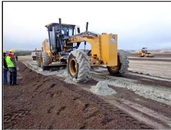
Figura 4. Estabilización de suelos con fines de pavimentación Nota: (Anticona, 2020)
