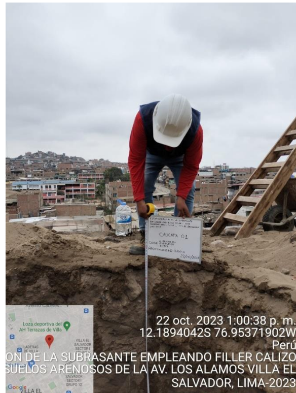
Fotografía 1. Exploración de la calicata N°1
