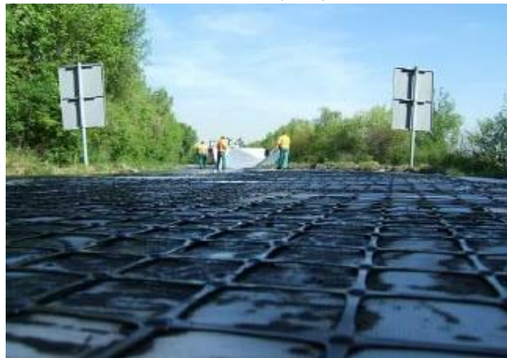
Ilustración 9. Colocación de Geomalla en la construcción de pavimentos Fuente: Navarro (2017).
