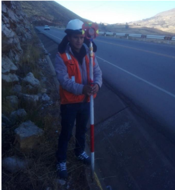
FIGURA 85 Levantamiento topográfico en el pie del talud.
