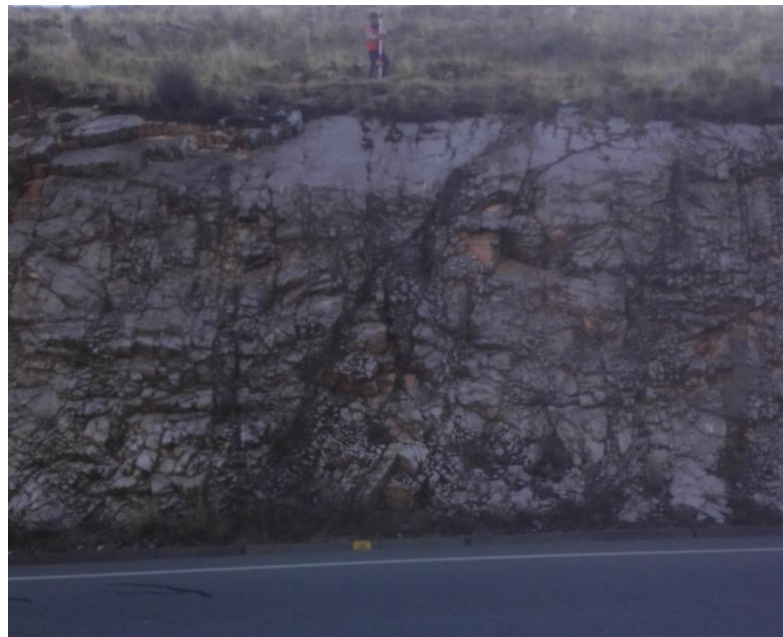
FIGURA 84 Levantamiento topográfico en la cumbre del talud.
