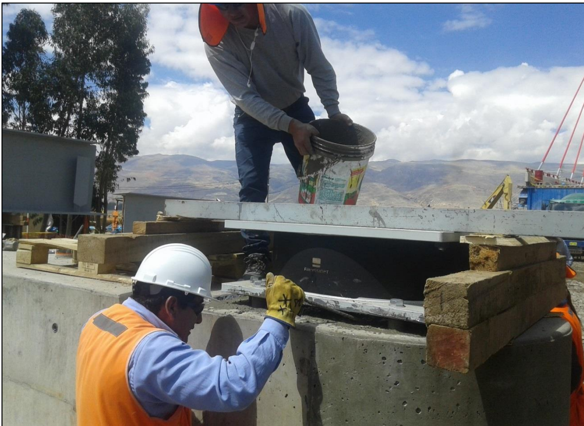
FOTOGRAFÍA N° 42 Colocación de grouting en la base del aislador sísmico.
