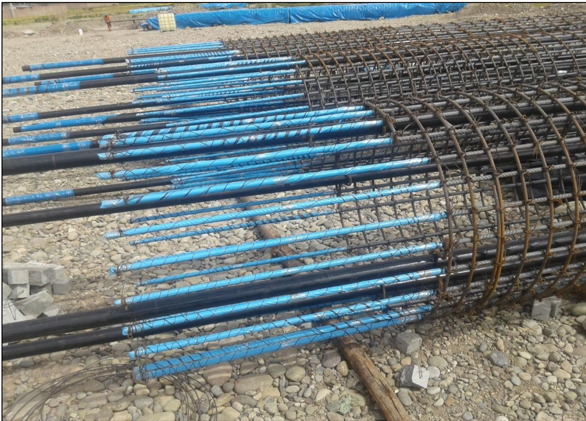
FOTOGRAFÍA N° 8 Colocación de fundas de polietileno en la parte superior del acero para evitar adherencia del concreto durante las labores de descabezado.
