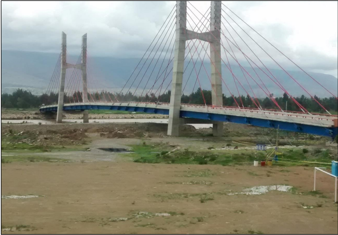
FOTOGRAFÍA N° 1 Vista general del puente Comunerós inconcluso.
