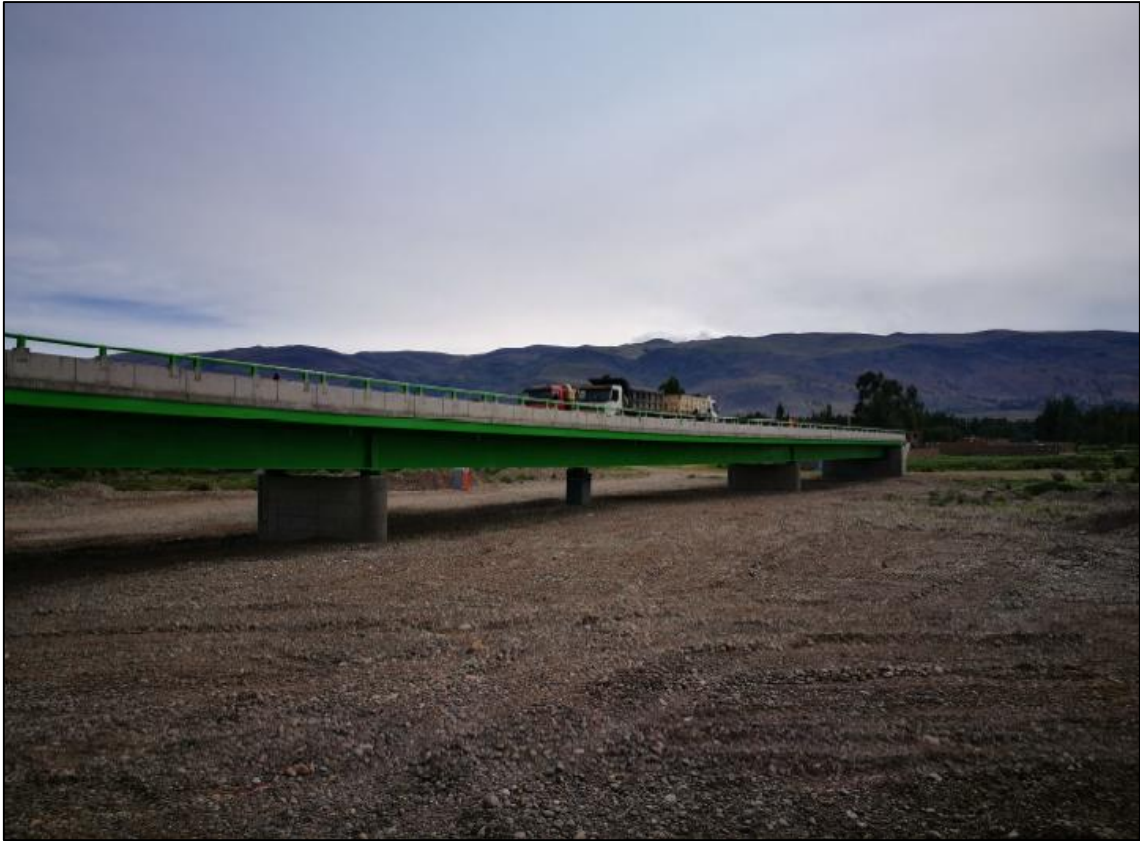
FOTOGRAFÍA N° 51 Prueba de carga con camiones de diseño.
