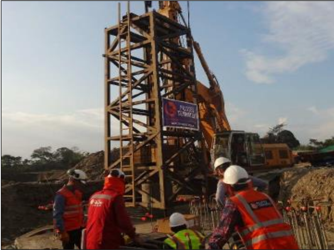
FOTOGRAFÍA N° 37 Realización de la prueba de carga dinámica.
