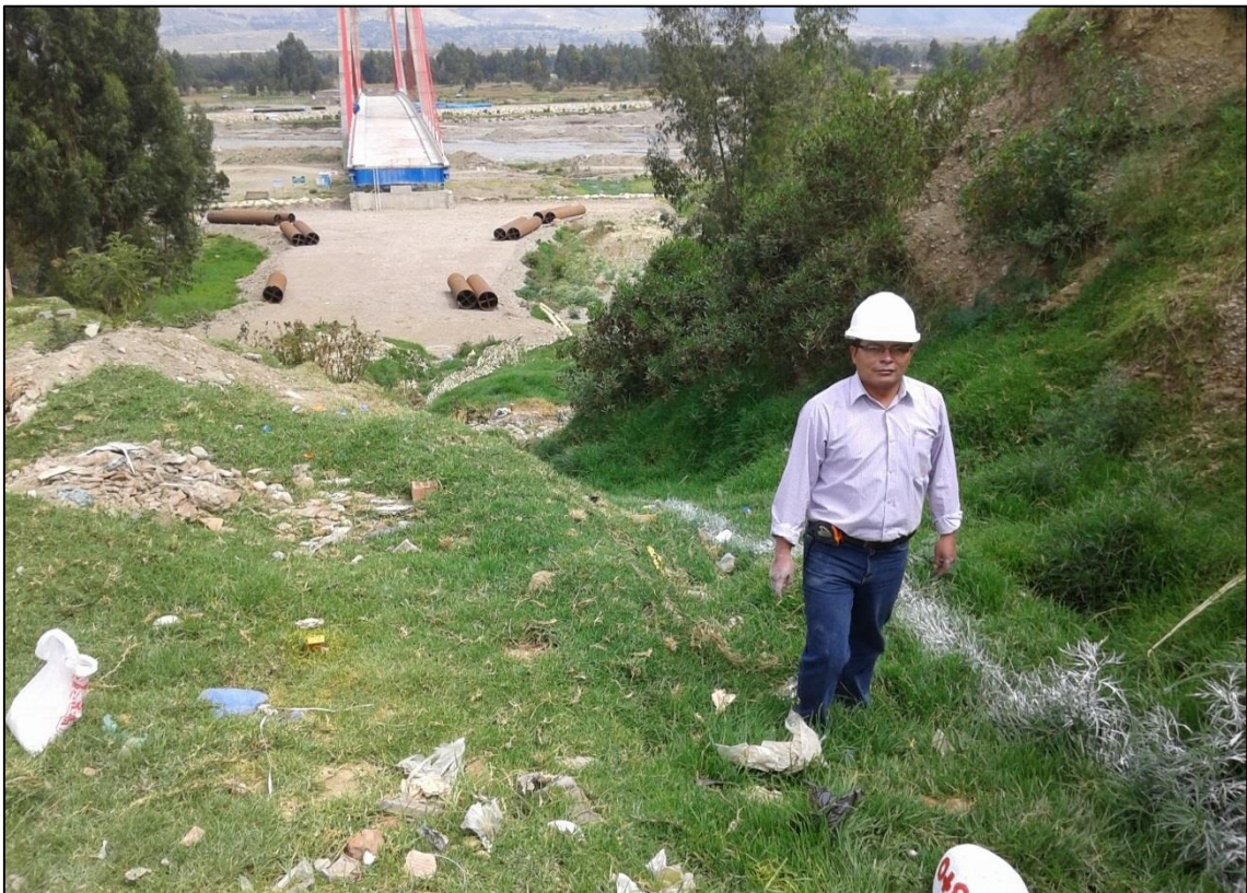
FOTOGRAFÍA N° 6 Apoyo en las labores de trazo y replanteo antes del inicio de la obra.
