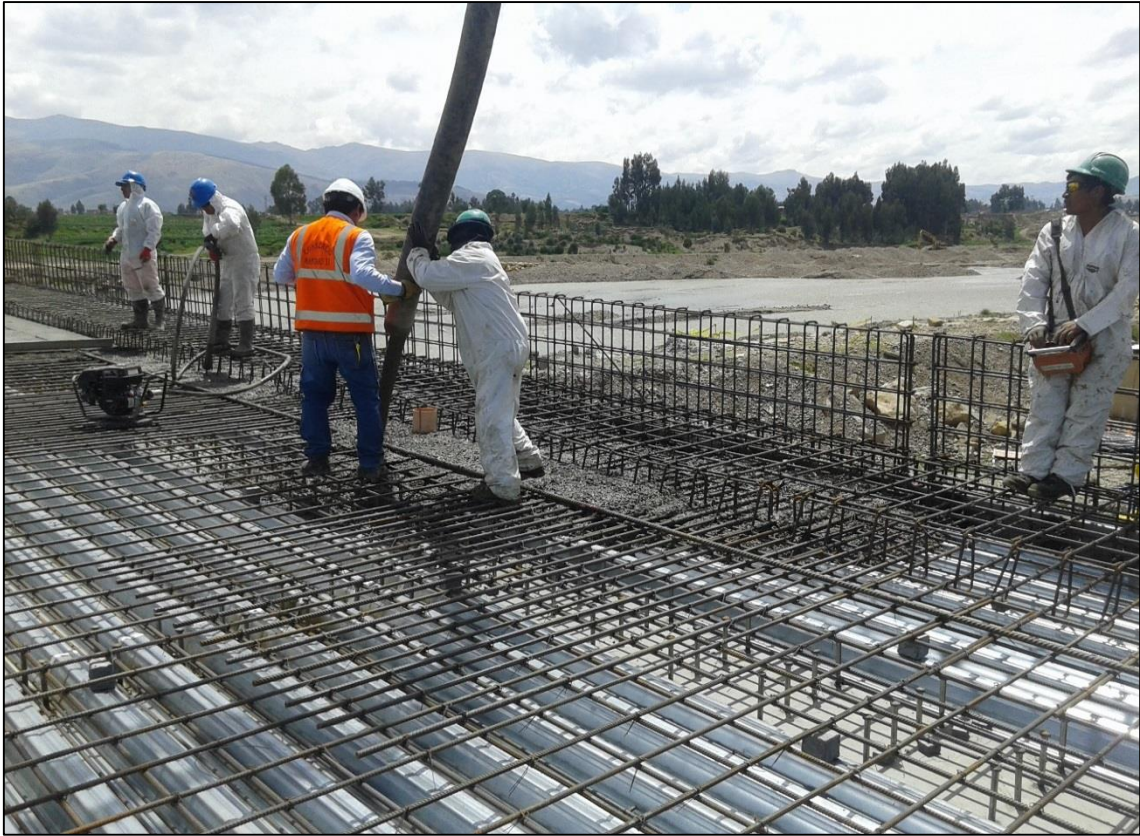
FOTOGRAFÍA N° 47 Colocación del concreto en la construcción de la losa de rodadura.
