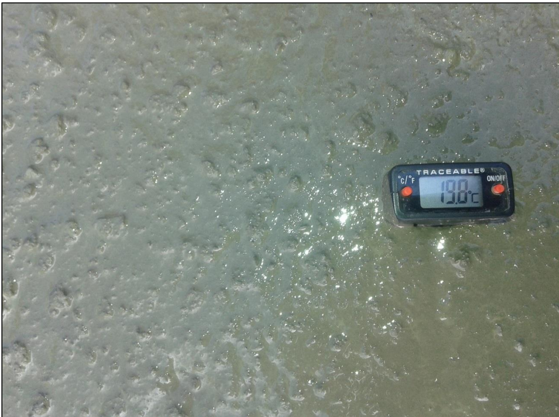
FOTOGRAFÍA N° 28 Determinación de la temperatura del concreto antes de ser colocado en el pilote.
