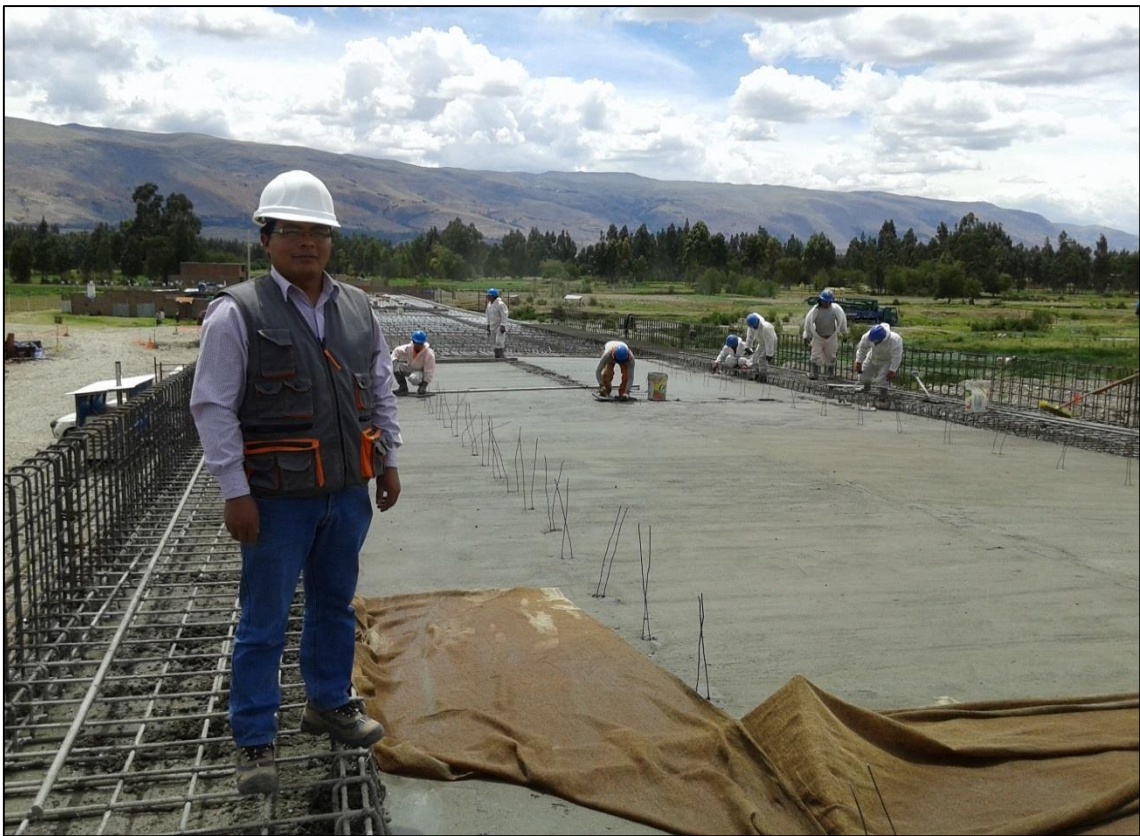
FOTOGRAFÍA N° 48 Acabado de la losa de rodadura del puente.
