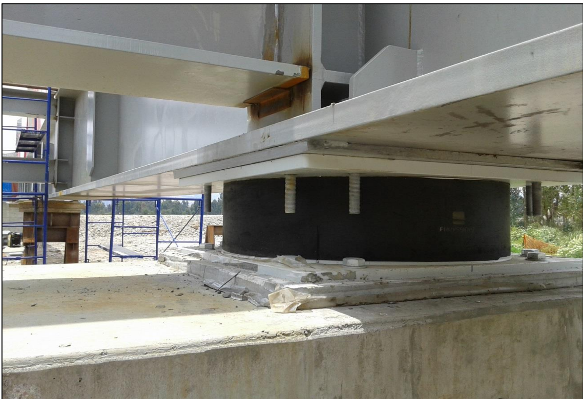
FOTOGRAFÍA N° 44 Aislador sísmico colocado entre el estribo y las vigas de acero que soportan la súper estructura.
