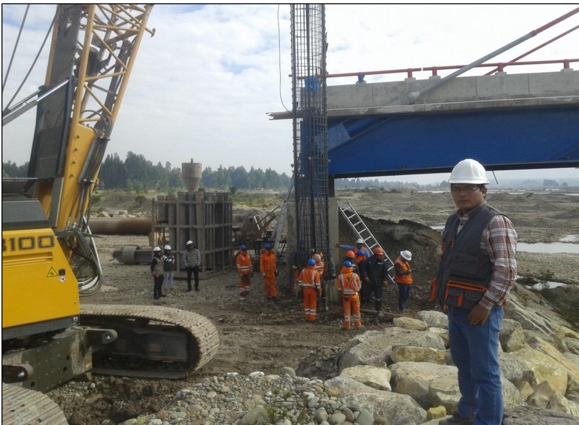
FOTOGRAFÍA N° 20 Colocación del refuerzo de acero de los pilotes con apoyo de la grúa de la pilotera.
