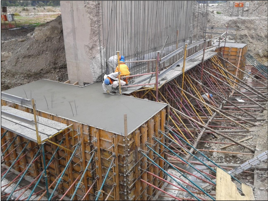
FOTOGRAFÍA N° 39 Colocación del concreto en el estribo 2 de la súper estructura.
