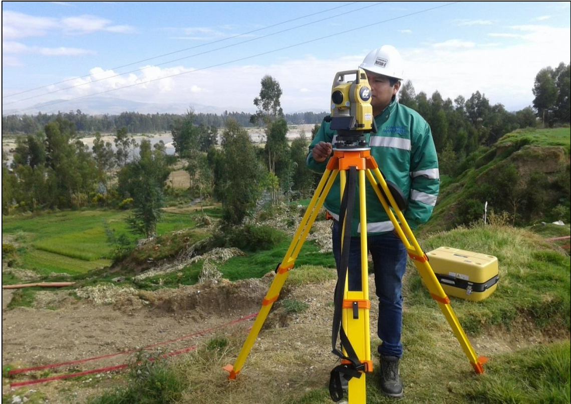
FOTOGRAFÍA N° 5 Labores de trazo y replanteo para la construcción de la obra.
