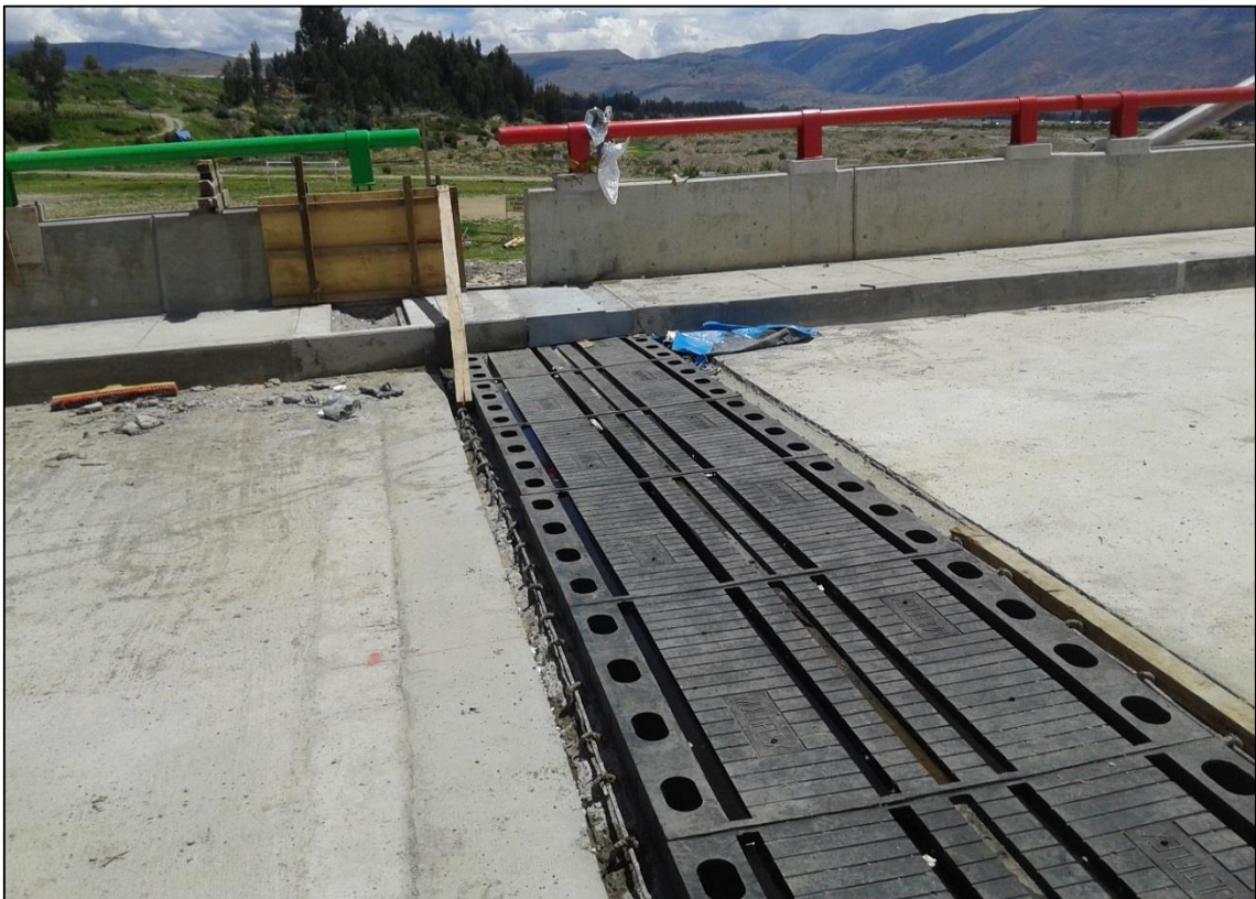
FOTOGRAFÍA N° 50 Colocación de la banda de caucho, entre la estructura atirantada y el acceso 1.
