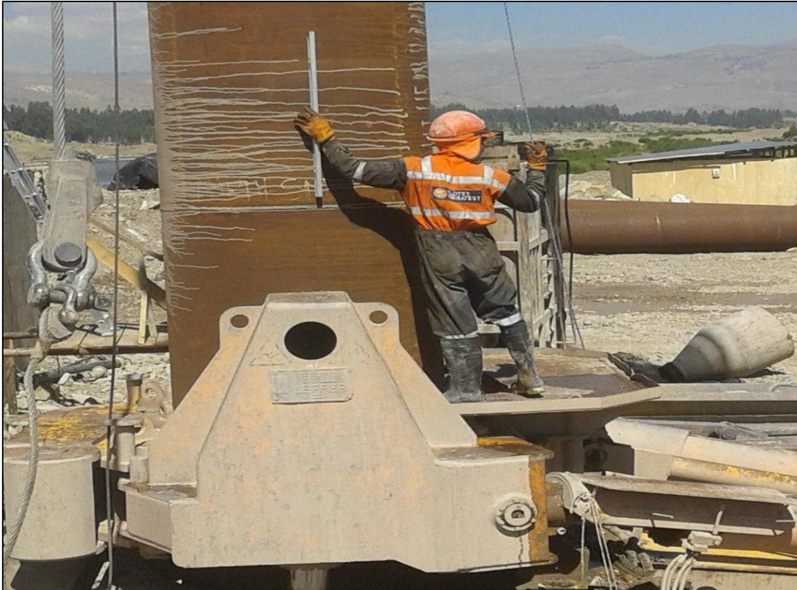
FOTOGRAFÍA N° 15 Ajuste de la verticalidad del encamizado con el uso de nivel de mano.
