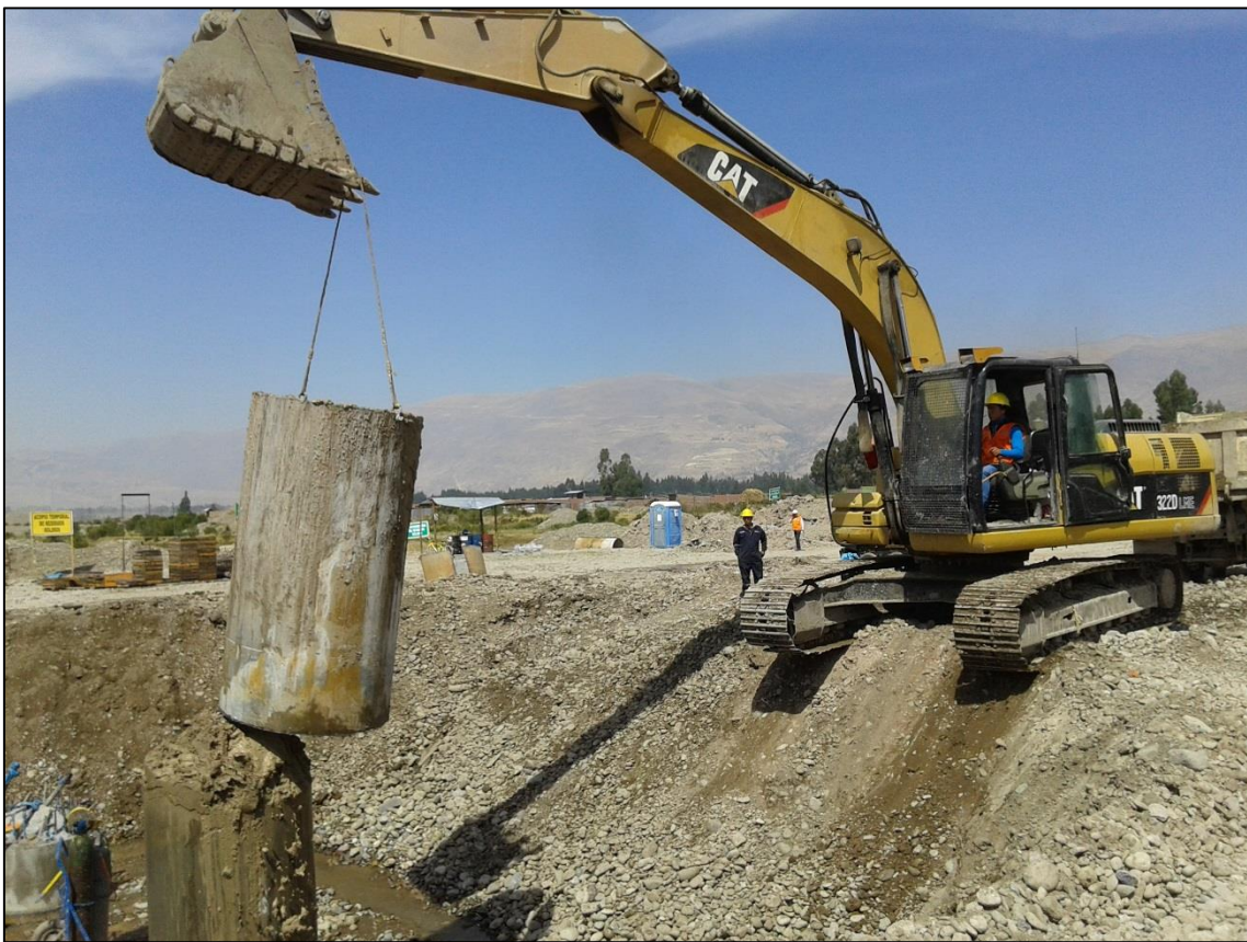
FOTOGRAFÍA N° 34 Extracción del encamizado metálico desde el nivel de base de la zapata.
