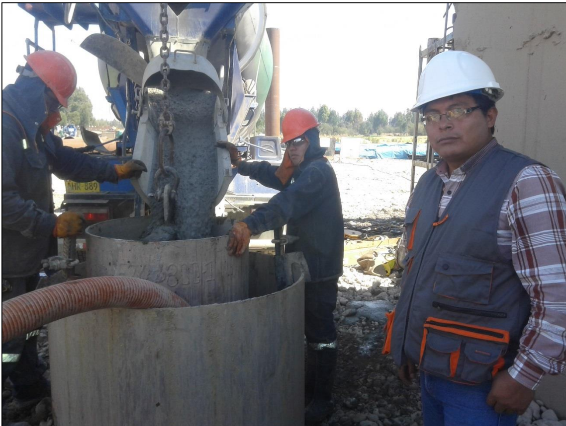
FOTOGRAFÍA N° 30 Colocación del concreto con la tubería Tremie.
