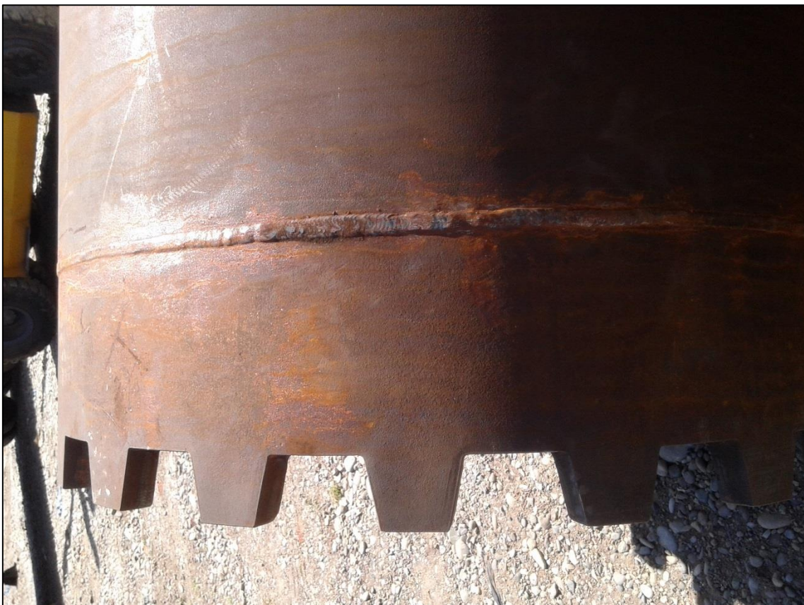
FOTOGRAFÍA N° 12 Detalle del dentado del encamizado que se fundirá conjuntamente con el pilote.
