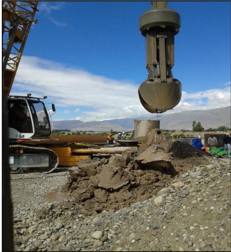
FOTOGRAFÍA N° 4.4 Material extraído durante la excavación de los pilotes.
