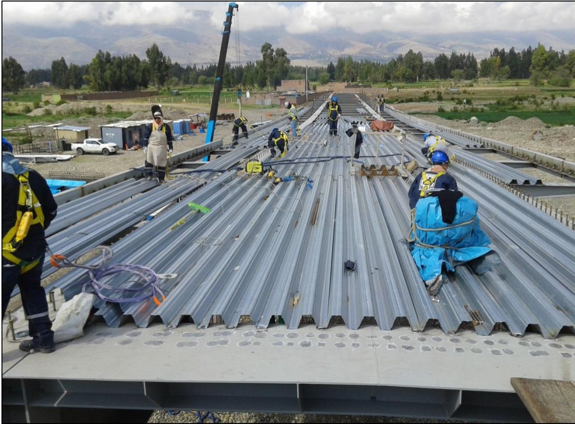
FOTOGRAFÍA N° 43 Colocación de placa colaborante.
