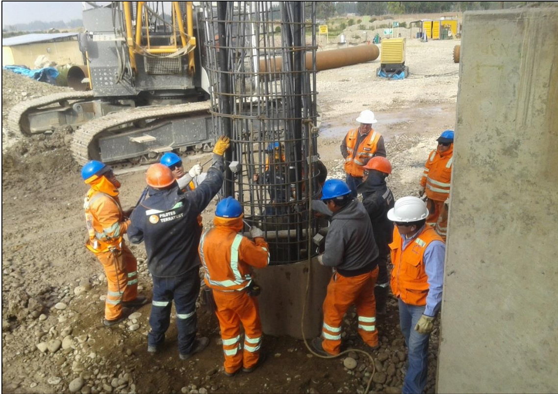
FOTOGRAFÍA N° 21 Colocación del acero de refuerzo y unión de los ductos para el ensayo de Cross Hole Sonic Logging.
