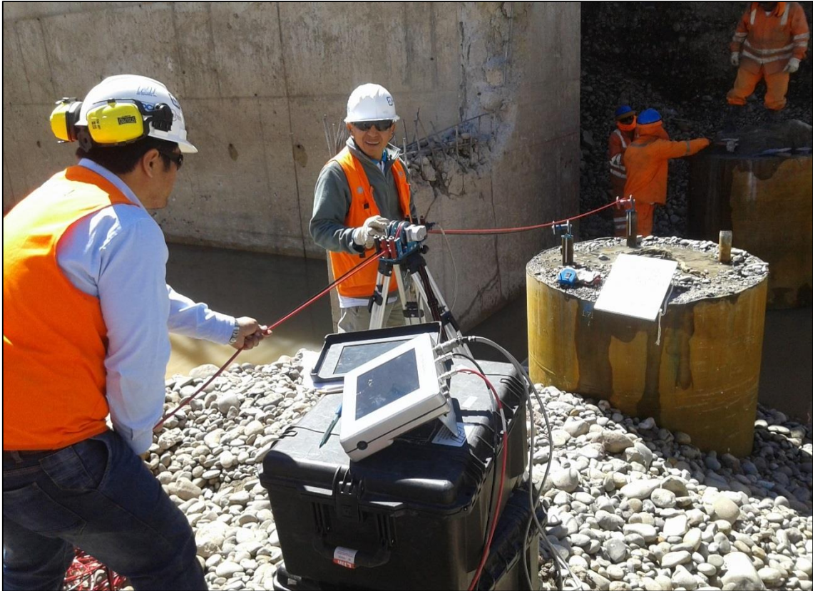
FOTOGRAFÍA N° 11 Realización del ensayo de Cross Hole Sonic Logging.
