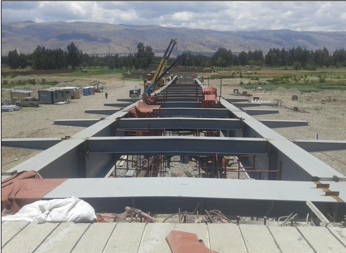
FOTOGRAFÍA N° 45 Vista general de las vigas longitudinales y arriostres transversales
