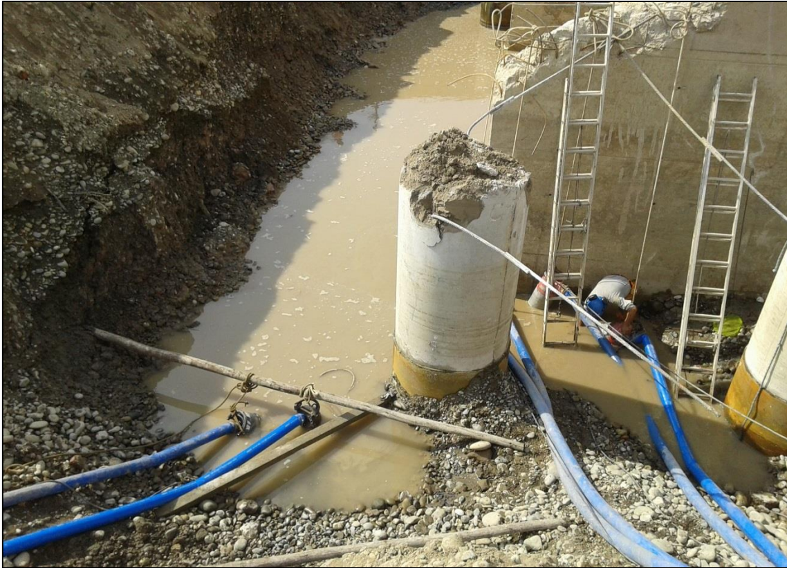
FOTOGRAFÍA N° 33 Extracción del agua expulsada de los acuíferos, para realizar el solado de la zapata de la pila y estribo.
