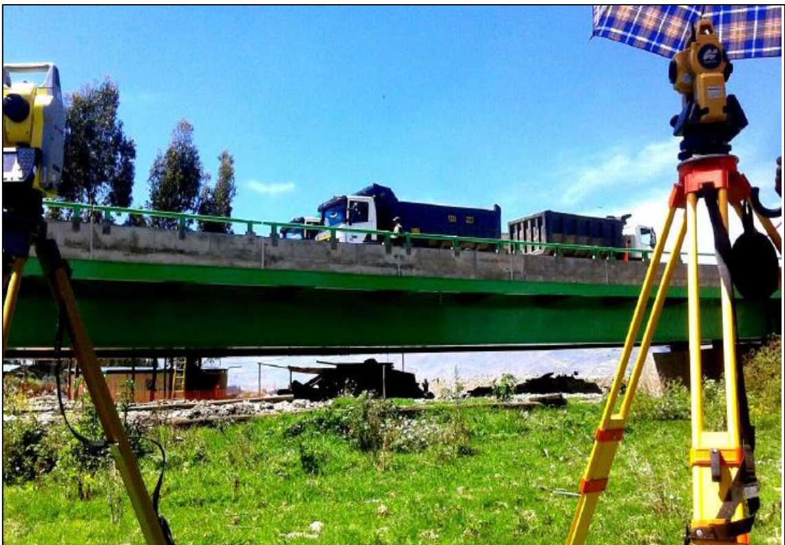
FOTOGRAFÍA N° 52 Toma de datos topográficos de la prueba de carga.
