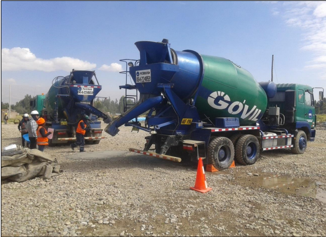
FOTOGRAFÍA N° 25 Llegada del concreto pre mezclado a la obra.
