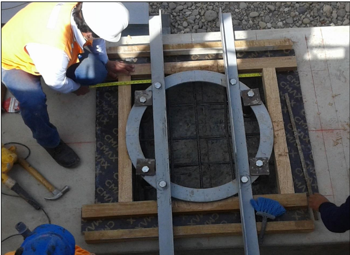
FOTOGRAFÍA N° 40 Fijación de la base para el aislador sísmico.
