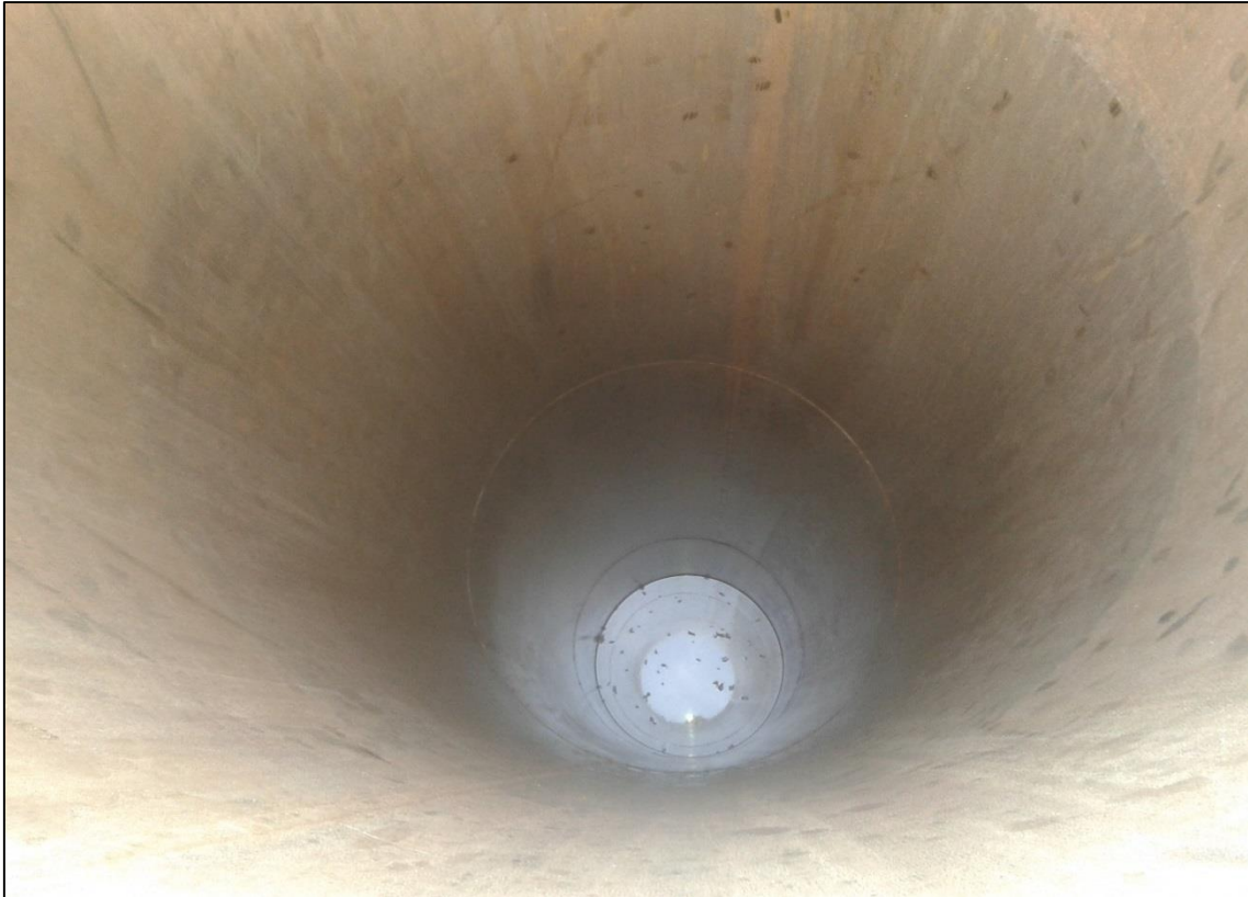
FOTOGRAFÍA N° 19 Encamizado fundido en el terreno listo para la colocación del refuerzo de acero y concreto.
