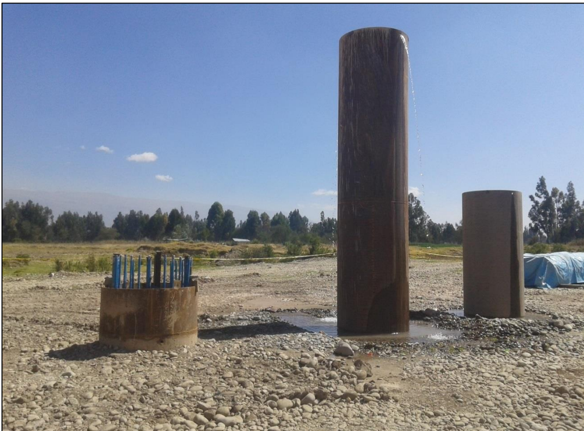
FOTOGRAFÍA N° 18 Elevación del nivel piezométrico del agua para estabilizar el flujo e iniciar las labores de colocación del concreto.
