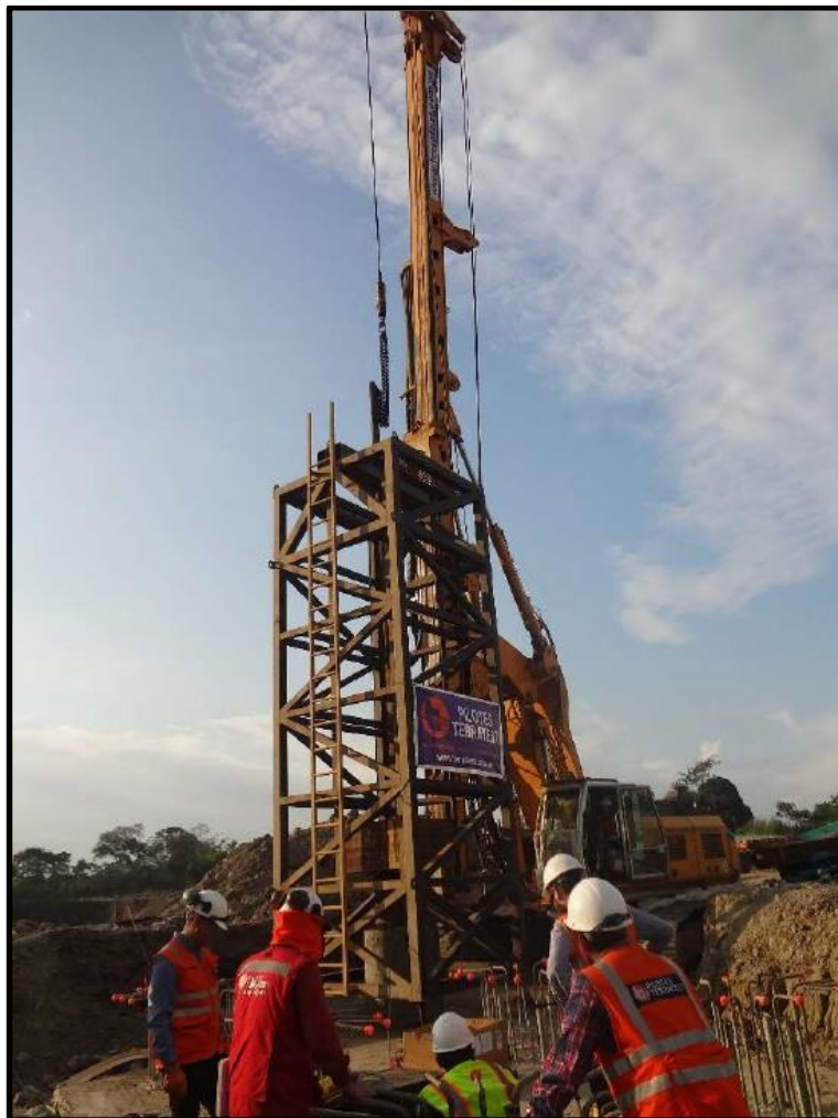
FOTOGRAFÍA N° 2.1 Marco de izaje y prueba de carga dinámica realizado por personal de la empresa Terratest.
