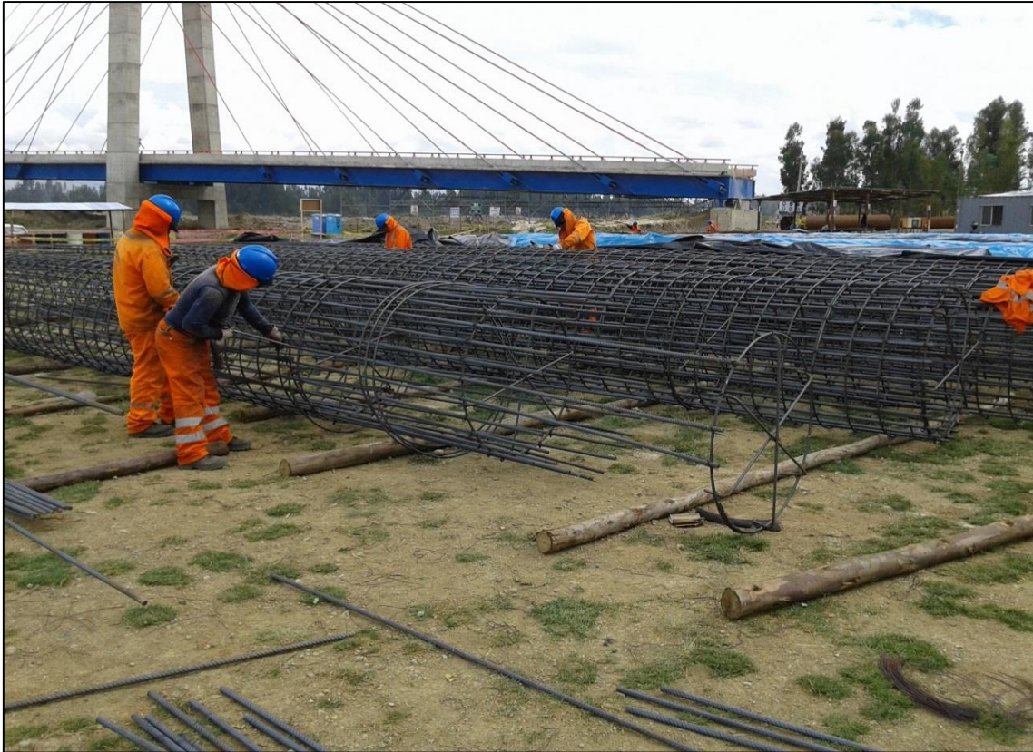
FOTOGRAFÍA N° 7 Habilitación de las estructuras de acero de refuerzo de los pilotes.
