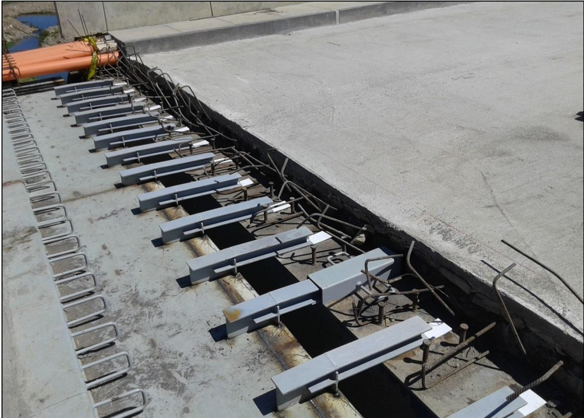
FOTOGRAFÍA N° 49 Fijación de los ejes de unión móvil entre el estribo y la losa de rodadura.
