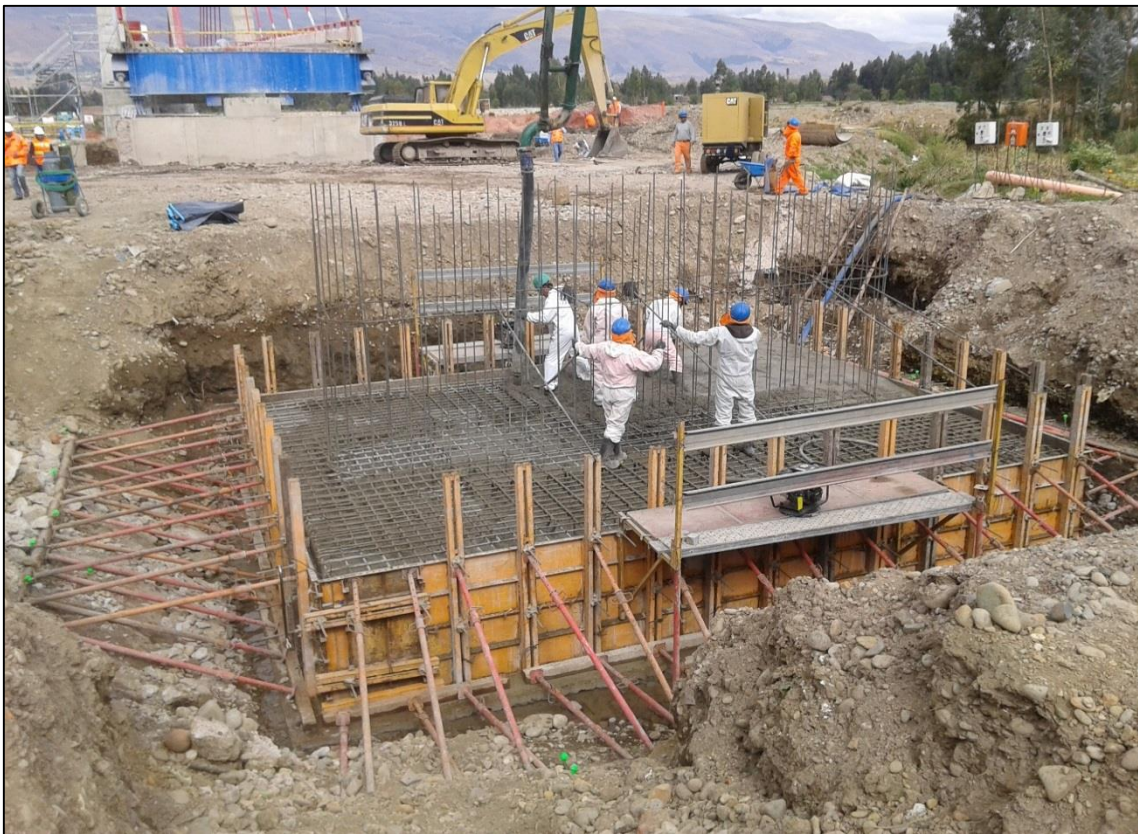
FOTOGRAFÍA N° 38 Colocación de concreto en la zapata de la súper estructura.
