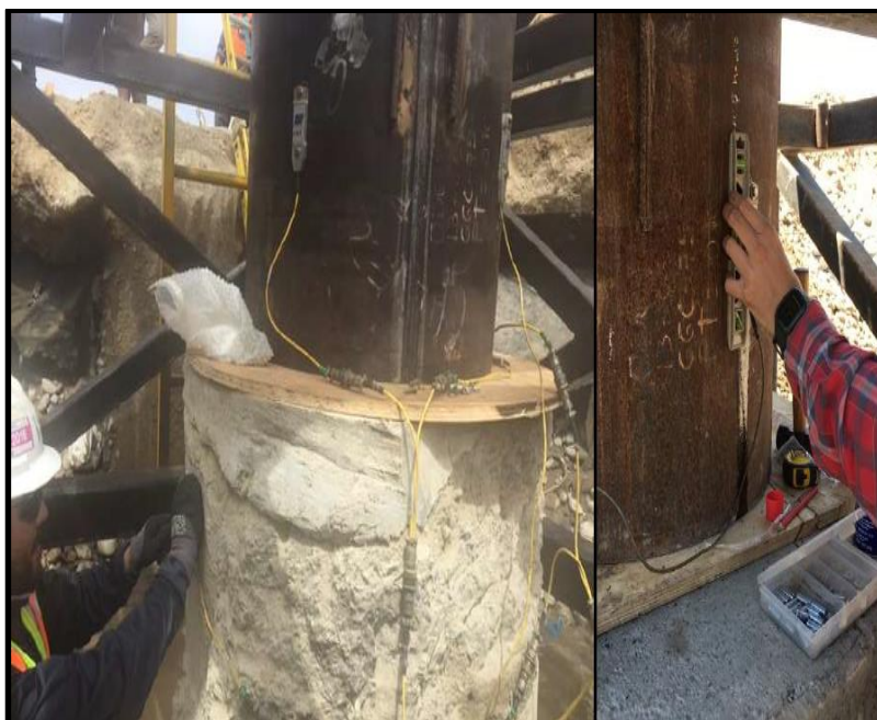
FOTOGRAFÍA N° 2.2 Instrumentación previa antes de la realización de la prueba de carga dinámica en pilotes.
