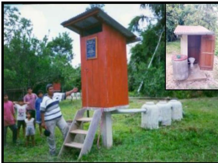
*Figura 4.* Letrina con “Cantaritos” y zanja de infiltración
