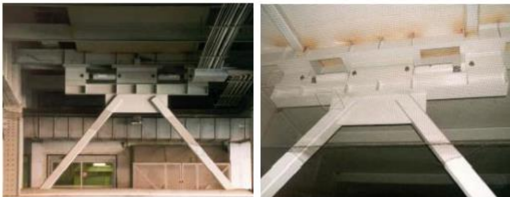
Fig. 1.17 Refuerzo adicional en la disposición Chevron
