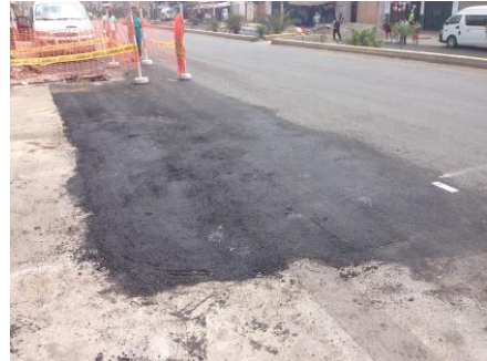
Reparación de la superficie con emulsión asfáltica, ubicado en la Prog. 5+380
