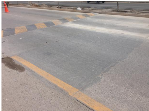
Reparación del paño, parchado superficial, ubicado en la Prog. 0+780
