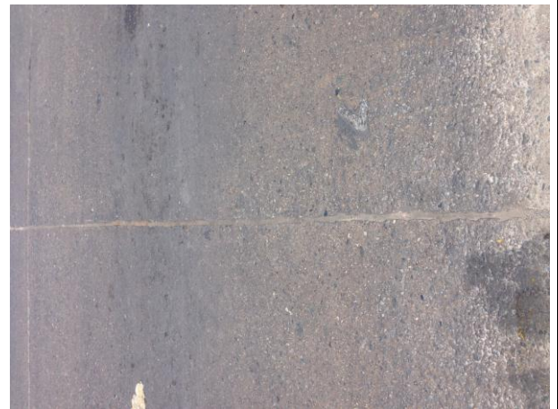
Reparación de junta, ubicada en la Prog. 3+820
