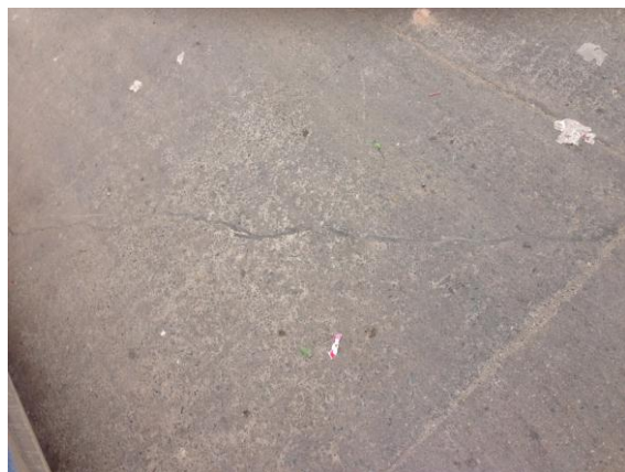
Reparación de fisura, ubicada en la Prog. 1+580
