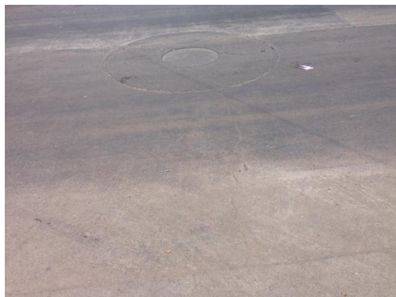
Reparación de fisura, ubicada entre las Prog. 1+720 – 1+740
