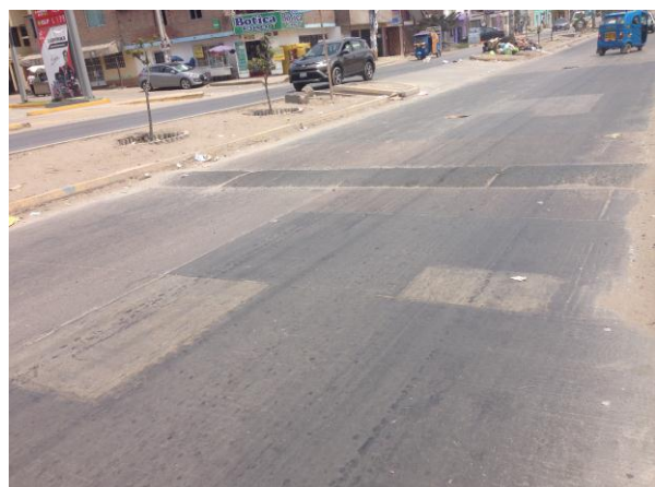
Reparación del paño, parchado superficial, ubicado en la Prog. 3+120
