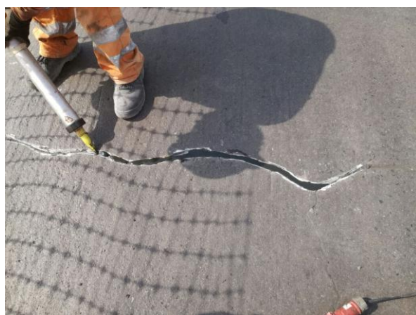
Reparación de fisura, ubicada en la Prog. 4+820
