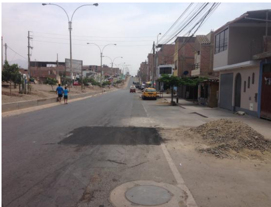
Reparación de la superficie con emulsión asfáltica, ubicado en la Prog. 6+100
