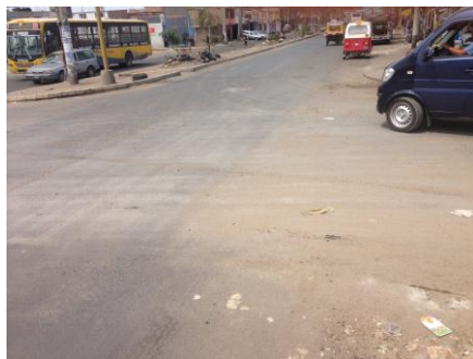
Reparación de la superficie con asfalto en caliente, ubicado cerca a la Av. Revolución.
