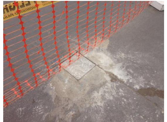
Reparación de esquina, ubicada en la Prog. 4+320
