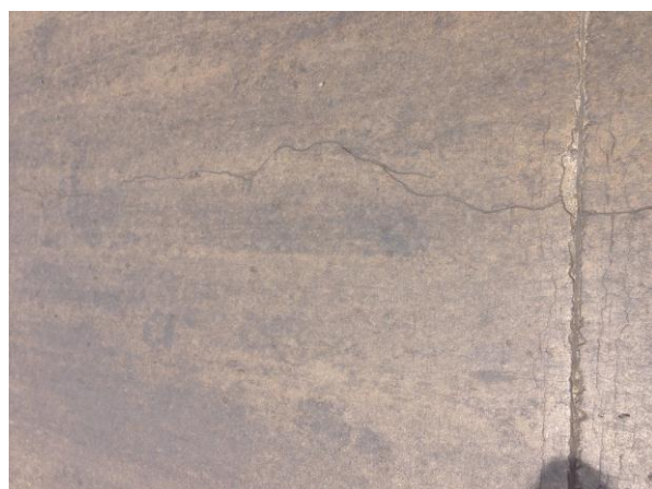
Reparación de fisura, ubicada entre las Prog. 3+940 – 3+960
