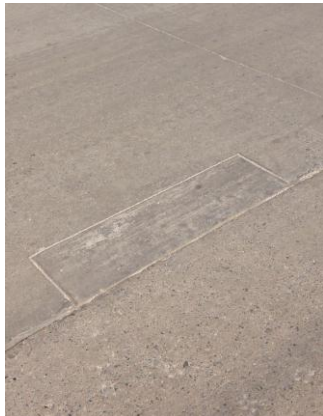
Reparación de esquina, ubicada en la Prog. 3+160
