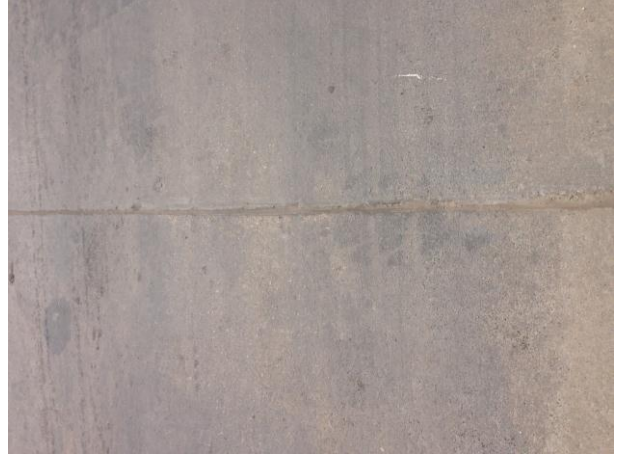
Reparación de junta, ubicada en la Prog. 2+620
