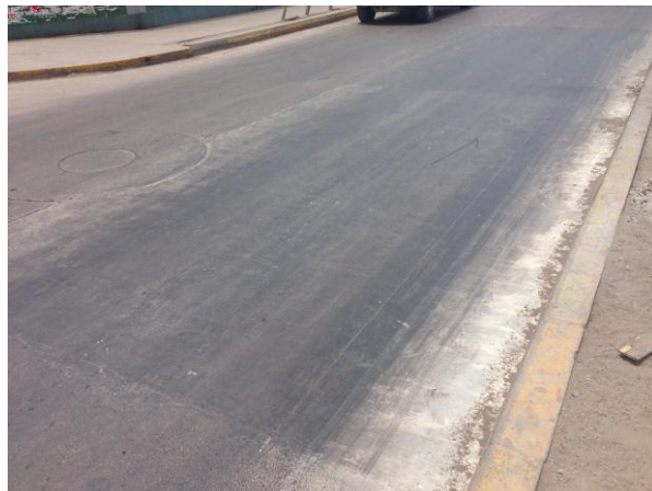
Reparación del paño, parchado superficial, ubicado en la Prog. 1+720 - 1+740
