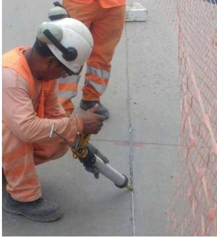
Reparación de junta, ubicada en la Prog. 2+180
