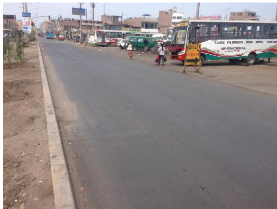
Reparación de la superficie con asfalto en caliente, ubicado cerca a la Av. Separadora Industrial.
