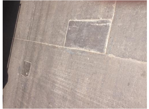
Reparación de esquina, ubicada en la Prog. 2+260
