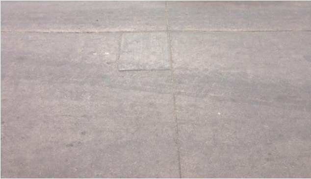
Reparación de esquina, ubicada en la Prog. 2+040
