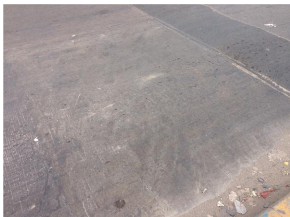
Reparación del paño, parchado superficial, ubicado en la Prog. 4+780
