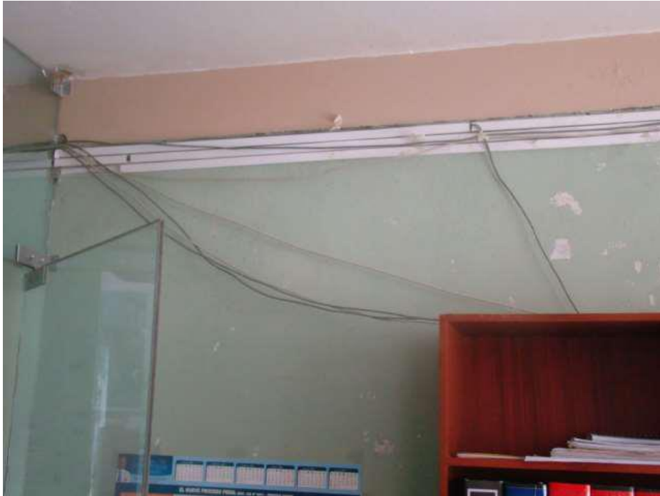
Fig. N° 5: red de datos actual en el área de Contabilidad Fuente: Municipalidad Distrital de Huamancaca. Elaboración: Propia
