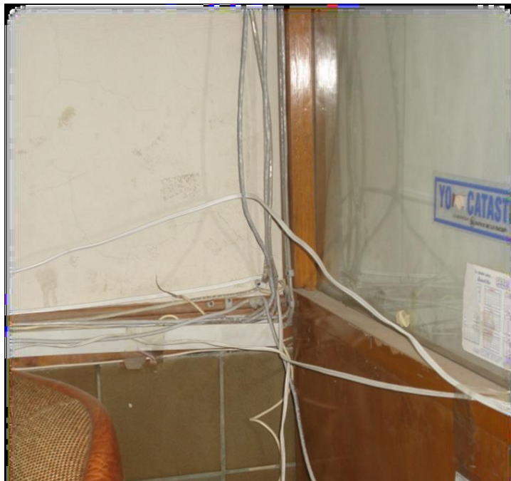
Figura N° 3: Estado de cableado de red 2do Piso. Fuente: Municipalidad de Huamancaca Chico. Elaboración: Propia
