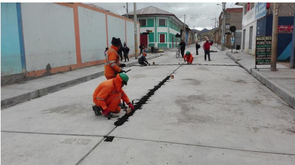
ASERRADO DE LAS JUNTAS DE CONTRACCION DE 6mm
