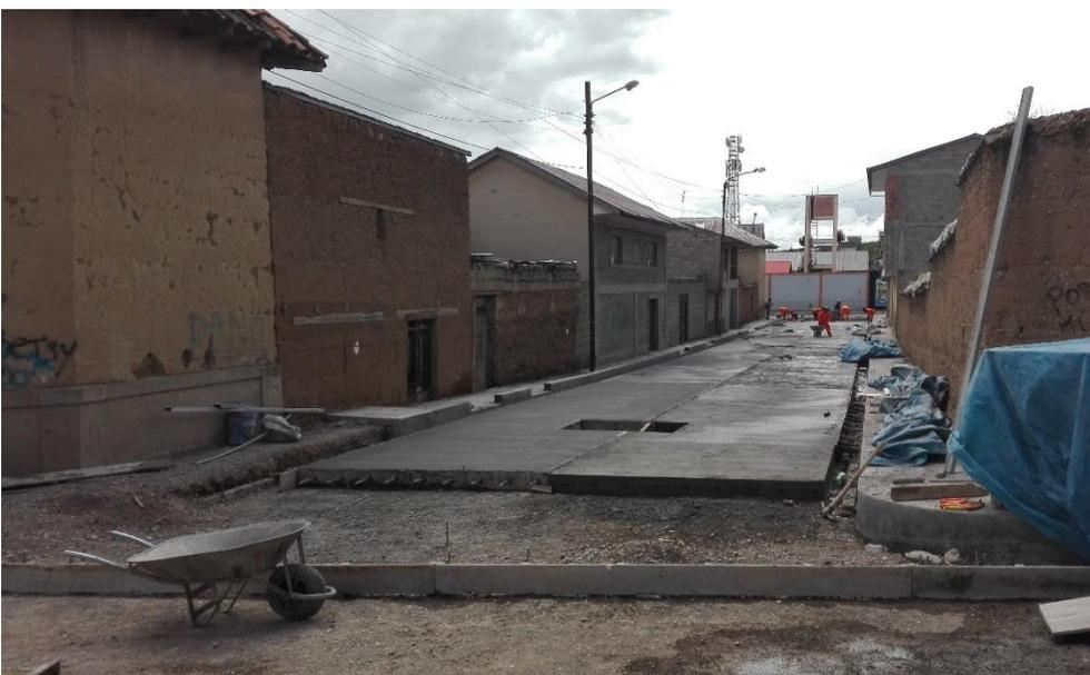
PERFILADO Y DEL TERRENO PARA LA CONSTRUCCION Y VACIADO DE LAS CUNETAS
